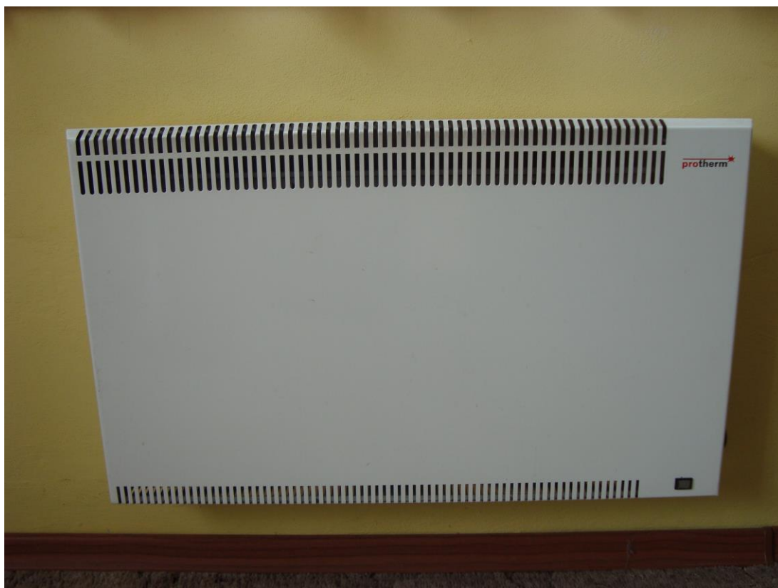
Obrázek 14 - Elektrický přímotop 2 kW
