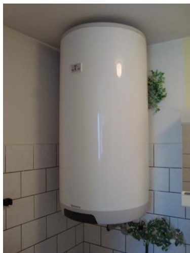
Obrázek 10 - Elektrický bojler
