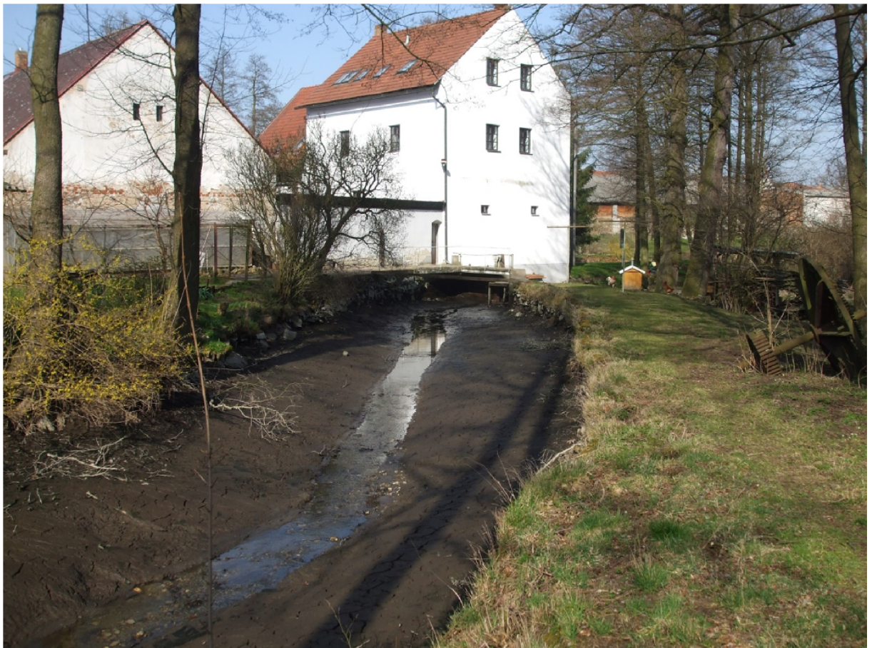
Obrázek 4-1 Pohled na stávající náhon vypuštěný kvůli čištění, vlastní foto
