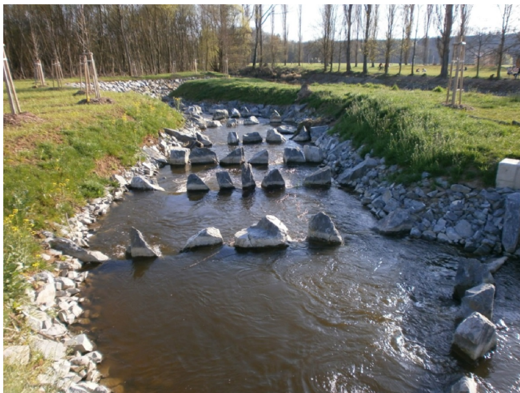
Obrázek 4.1-3 Peřejový rybí přechod v Plzni - Hradišti, vlastní foto
