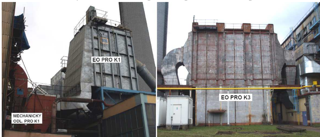
Obr. 9: Mechanický odlučovač a EO pro K1 v porovnání s EO pro K3
