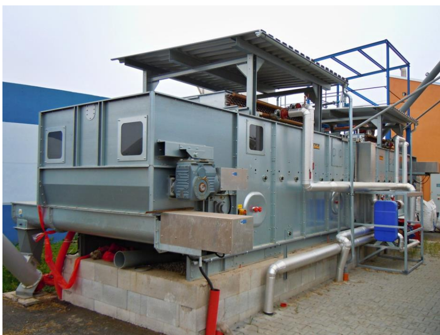
Obrázek 13: Pásová sušárna Stella 500 kW v BPS Černotín
