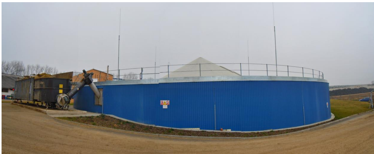
Obrázek 10: Fermentor s dávkovacím zařízením v BPS Černotín
