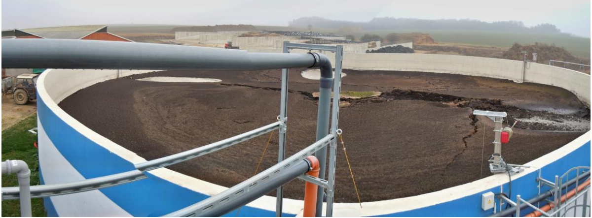
Obrázek 4: Koncový sklad digestátu
