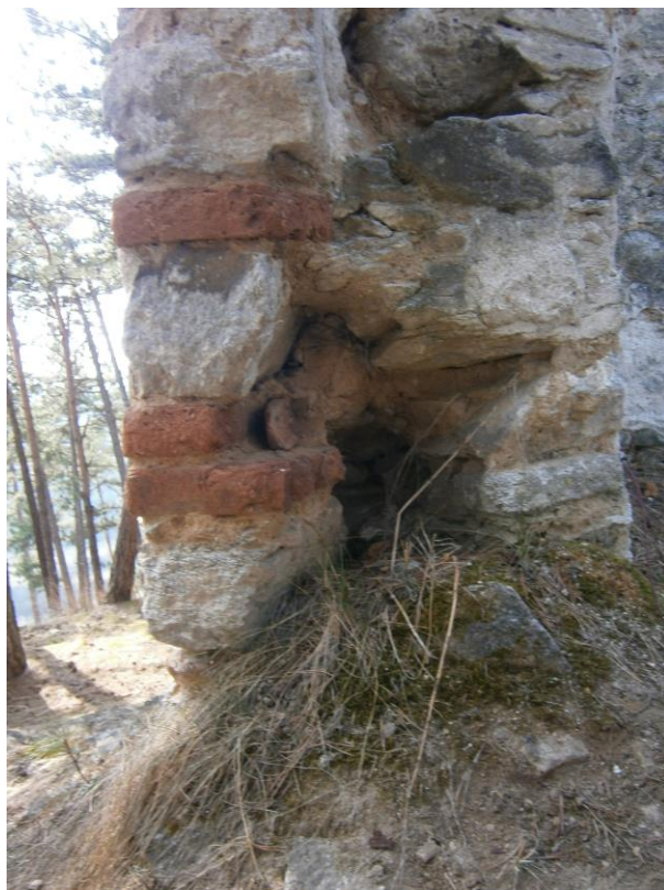
Obr. 24. Severní vstup, kapsa
