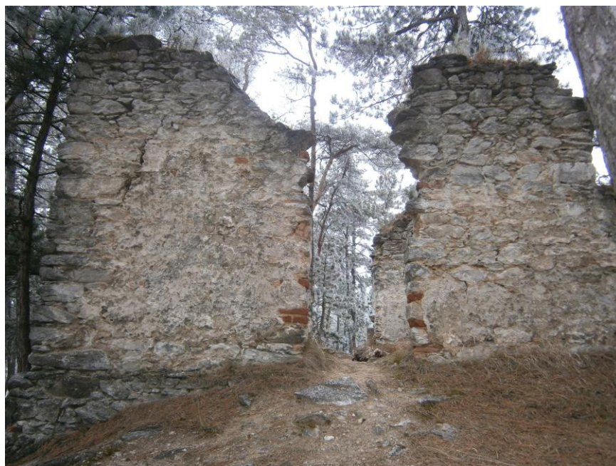
Obr. 22. Snímek vstup z jihu (exteriér)
