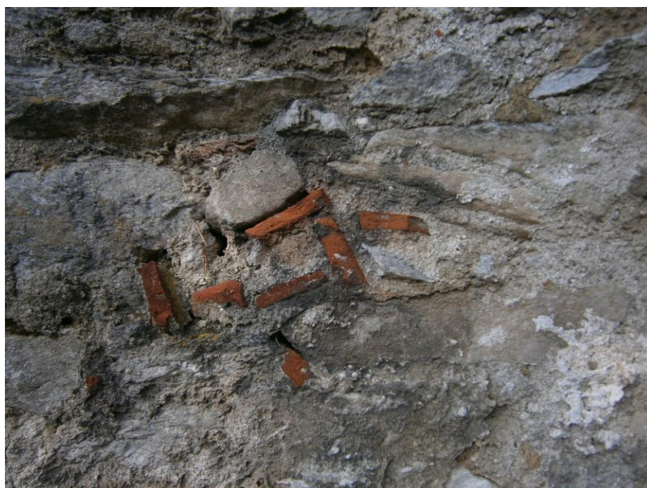
Obr. 25. Detail použitých prežů
