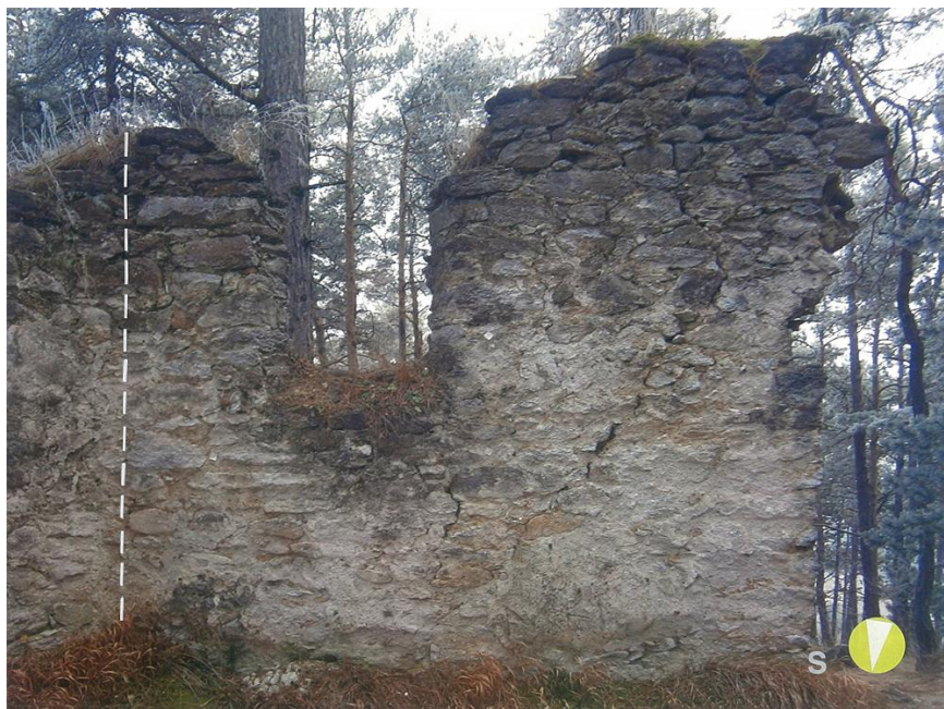
Obr. 19. Kolmý snímek jižní stěna první část (interiér)
