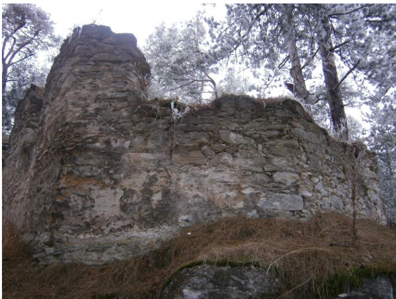
Obr. 34. Presbytář jihovýchodní pohled
