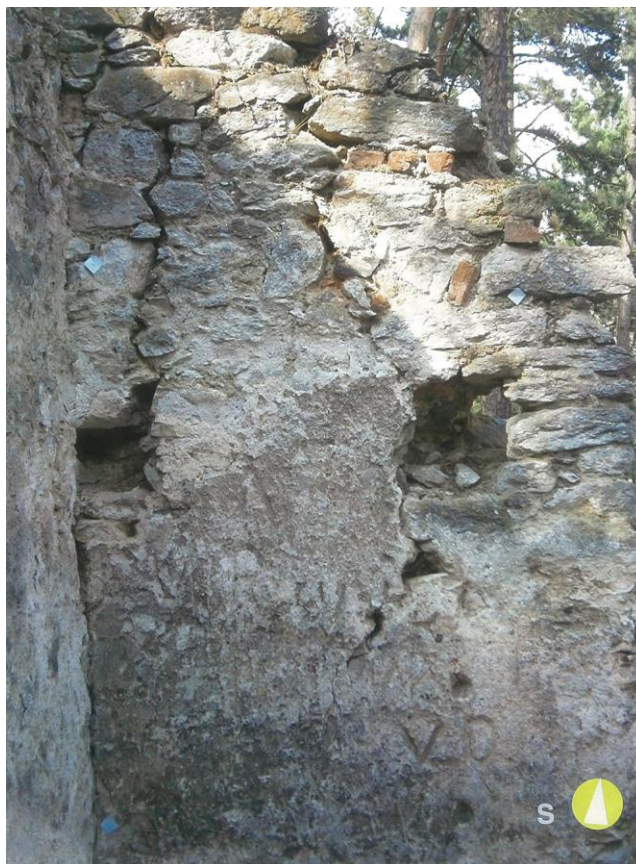
Obr. 21. Kolmý snímek severní stěna druhá část s kapsami (interiér)
