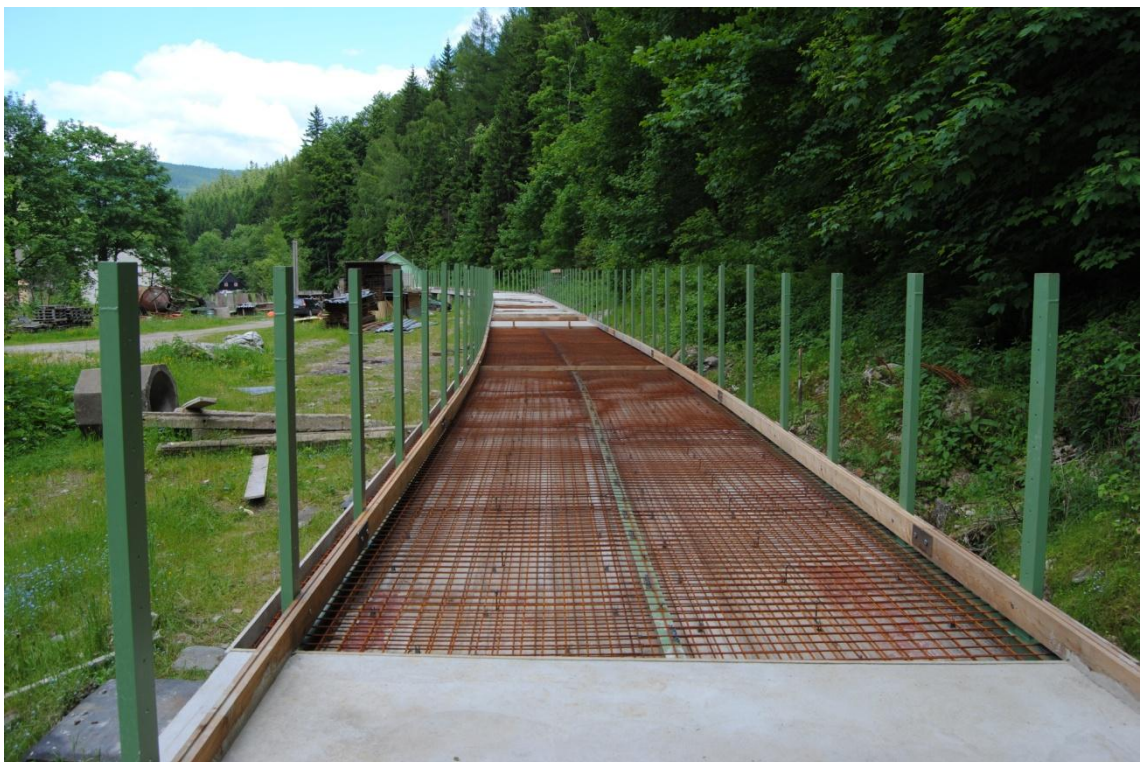
Obr. 8: Nově budovaný náhon k malé vodní elektrárně s obnaženou armaturou připravenou k zabetonování (zdroj: Šimon Kokoška, 13. 6. 2013).
