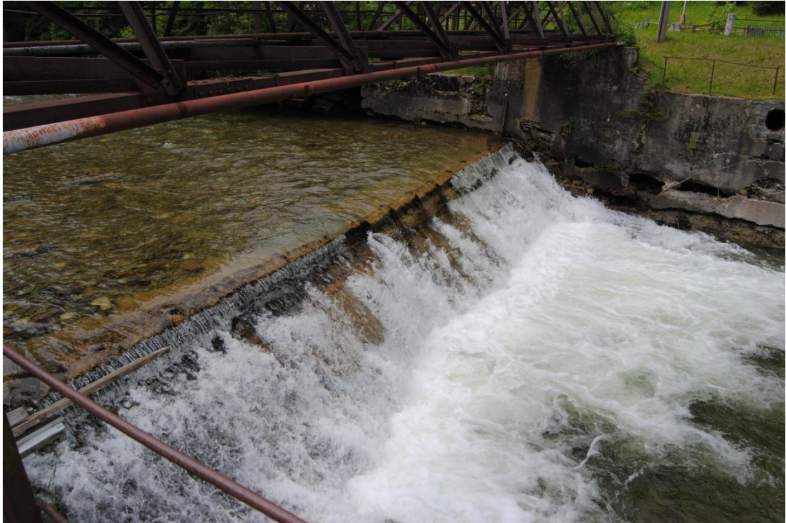
Obr. 7: Jez označený jako Úpa-O-3 do budoucna zajišťující odběr vody pro nově budovaný náhon (zdroj: Šimon Kokoška, 13. 6. 2013).
