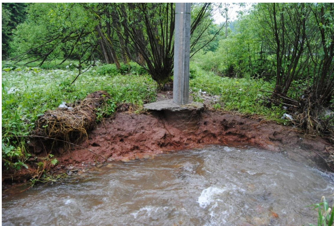
Obr. 18: Babský potok, podzemleté betonové základy sloupů elektrického vedení (zdroj: Šimon Kokoška, 11. 6. 2013).
