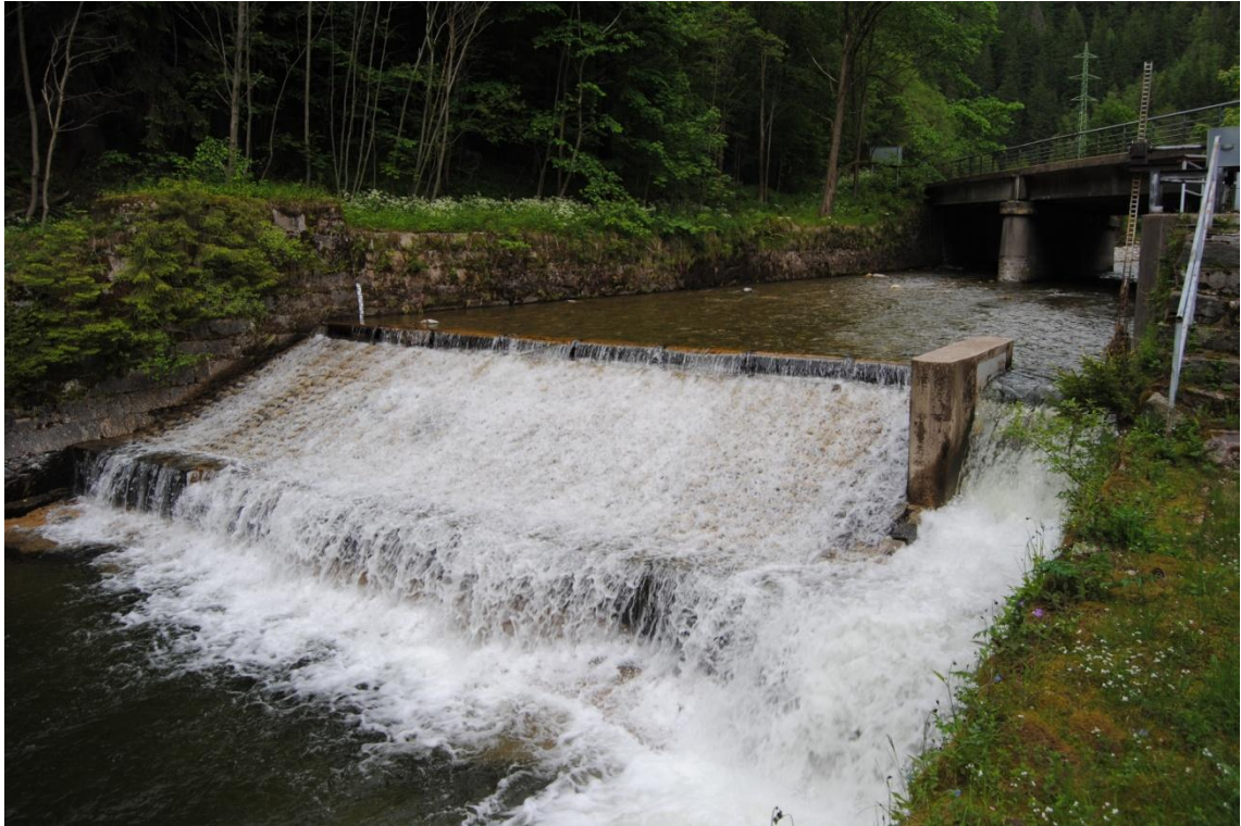
Obr. 5: Jez označený jako ÚPA-O-ID2 zajišťující odběr vody pro MVE-Temný Důl (zdroj: Šimon Kokoška, 13. 6. 2013).
