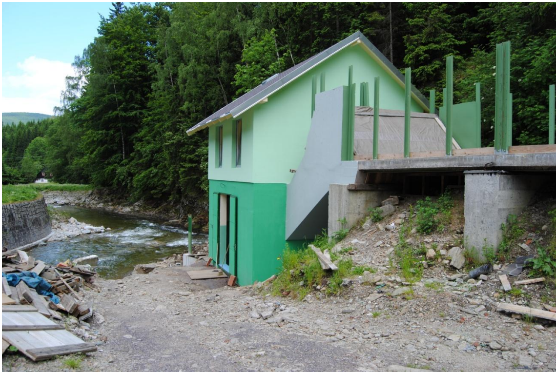
Obr. 9: Objekt nově budované MVE na souřadnicích GPS N 50.66385°, GPS E 15.79977° (zdroj: Šimon Kokoška, 13. 6. 2013).
