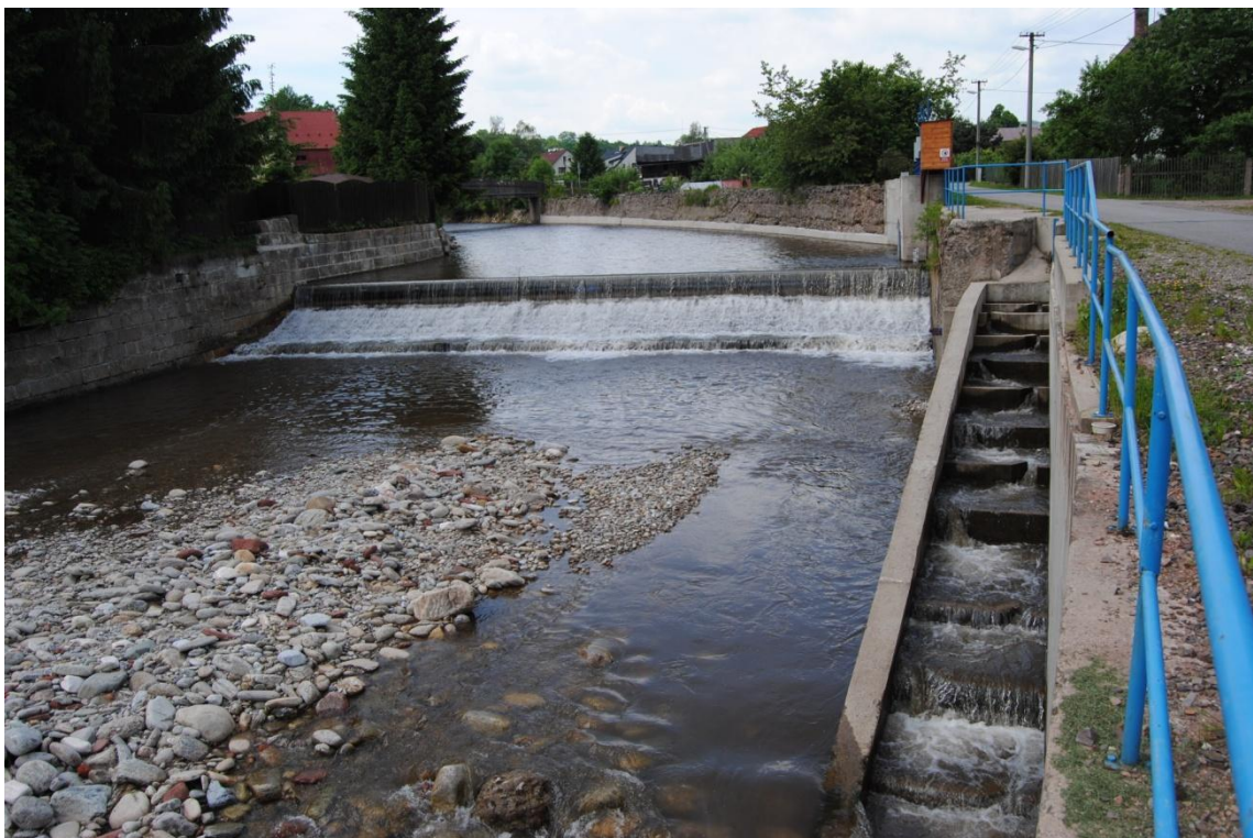
Obr. 10: Jez označený jako Úpa-O-ID12 zajišťující odběr vody pro MVE-Havran s rybím přechodem (zdroj: Šimon Kokoška, 13. 6. 2013).
