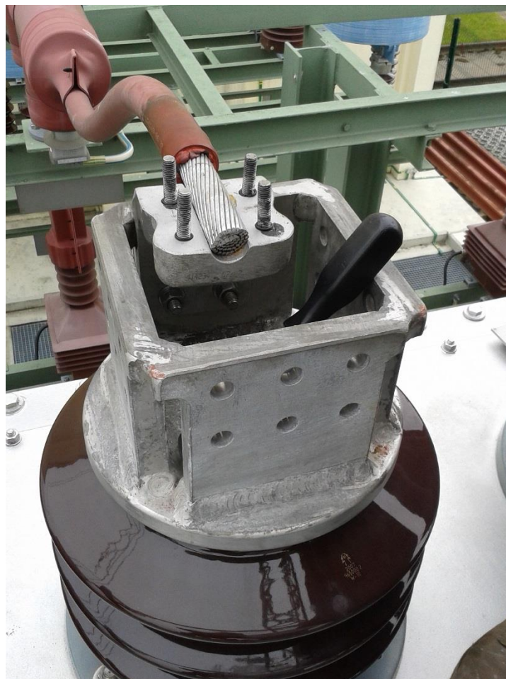
Obr. 3.4 připojení kabelu k průchodce
