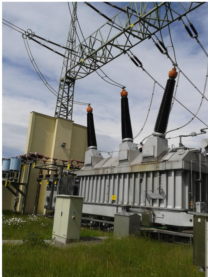
Obr. 1.2 moderní transformátorové průchodky
