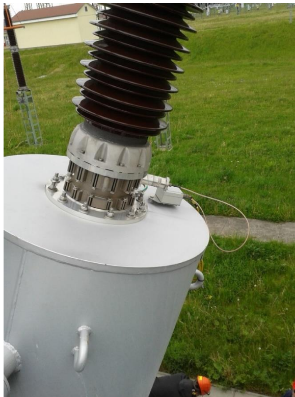
Obr. 5.1 senzor na průchodce
