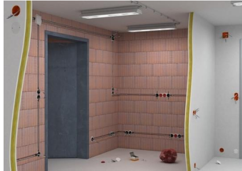
Obr.1.7.7-1 Ukázka kladení vedení pod omítku (převzato z [12])
