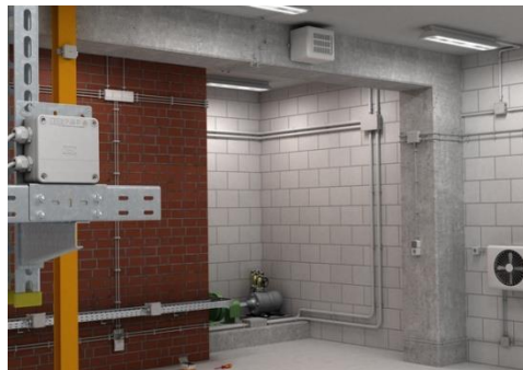
Obr.1.7.7-2 Ukázka kladení vedení po povrchu (převzato z [12])
