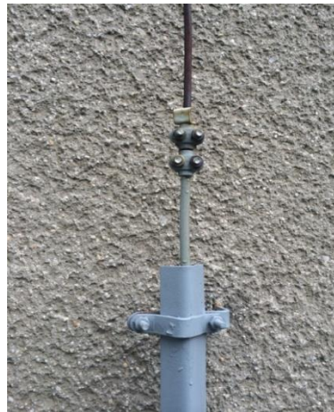
Obr.1.9.4-1 Zkušební svorka objektu bytové zástavby
