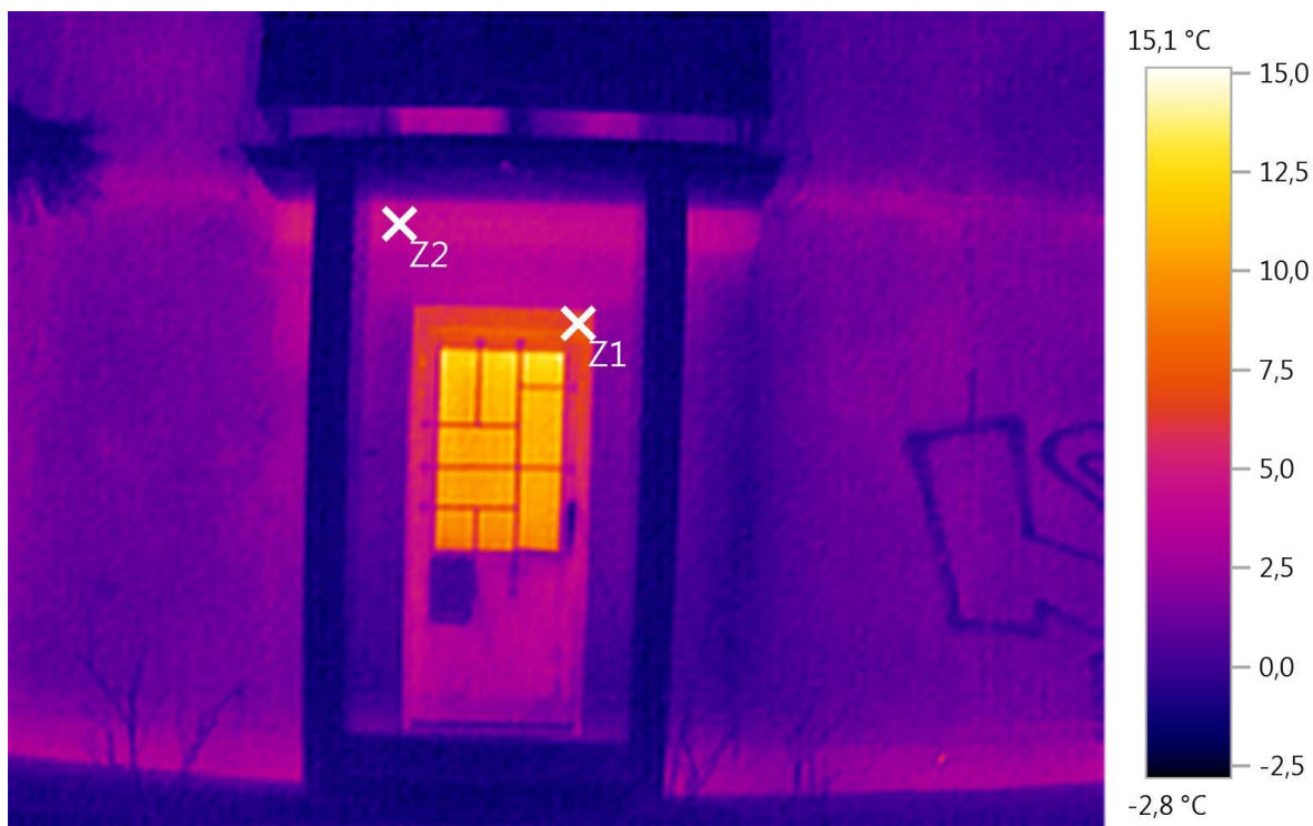
Obr. 4.11 Dveře na jihozápadní straně budovy
