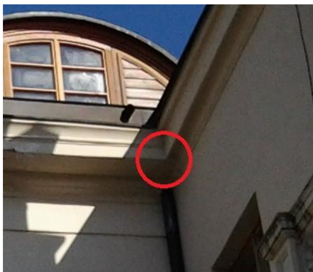
Obr. 3.1 Roh zakrytý okapem
