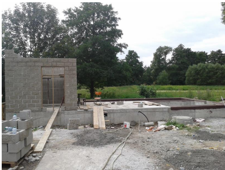
Obrázek 6 – Výstavba mechanicko-biologické ČOV Dlouhá Lomnice
