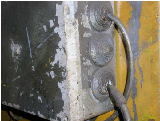
Příloha H: Poškozená kabeláž a špatná izolace
