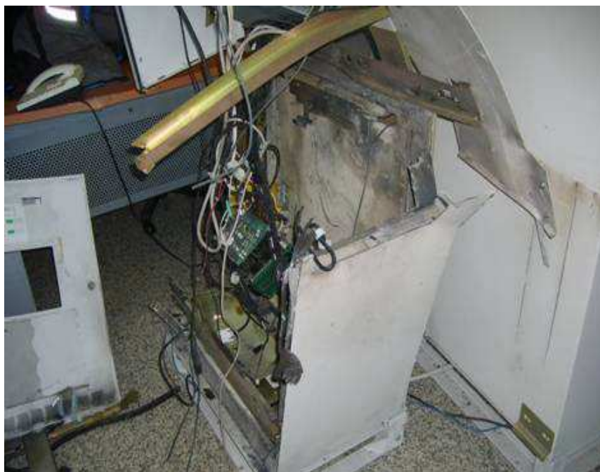
Obr.12 Destrukce trezorové části
