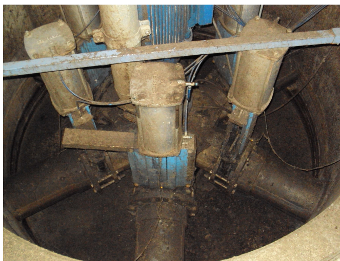
Obrázek 6: Přečerpávací jednotka
