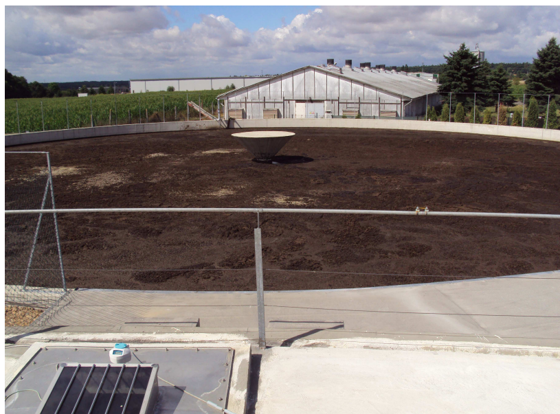
Obrázek 9:Koncový sklad digestátu
