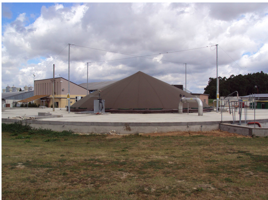
Obrázek 4: Dvoustupňový fermentor
