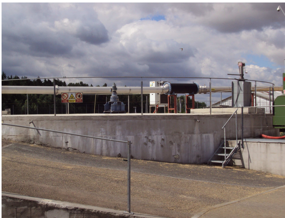
Obrázek 2: Předfermentor na drůbeží trus
