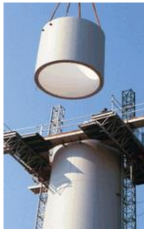
Obr. 2.19 Sestavování betonového stožáru VTE
