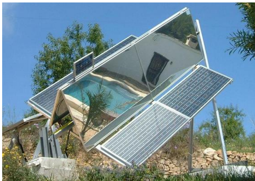
Obr. 20 Fotovoltaické panely s koncentrátory a sledovače typu Traxle [27]
