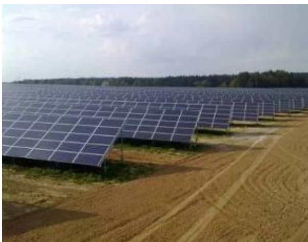
Obr. 27 Fotovoltaická elektrárna Ševětín [12]
