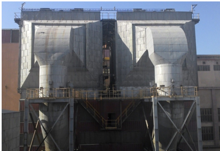
Obr. 3.2 Elektroodlučovače K9
