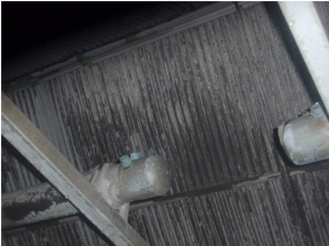
Obr. 2.6 Odlučovač kapek v absorběru
