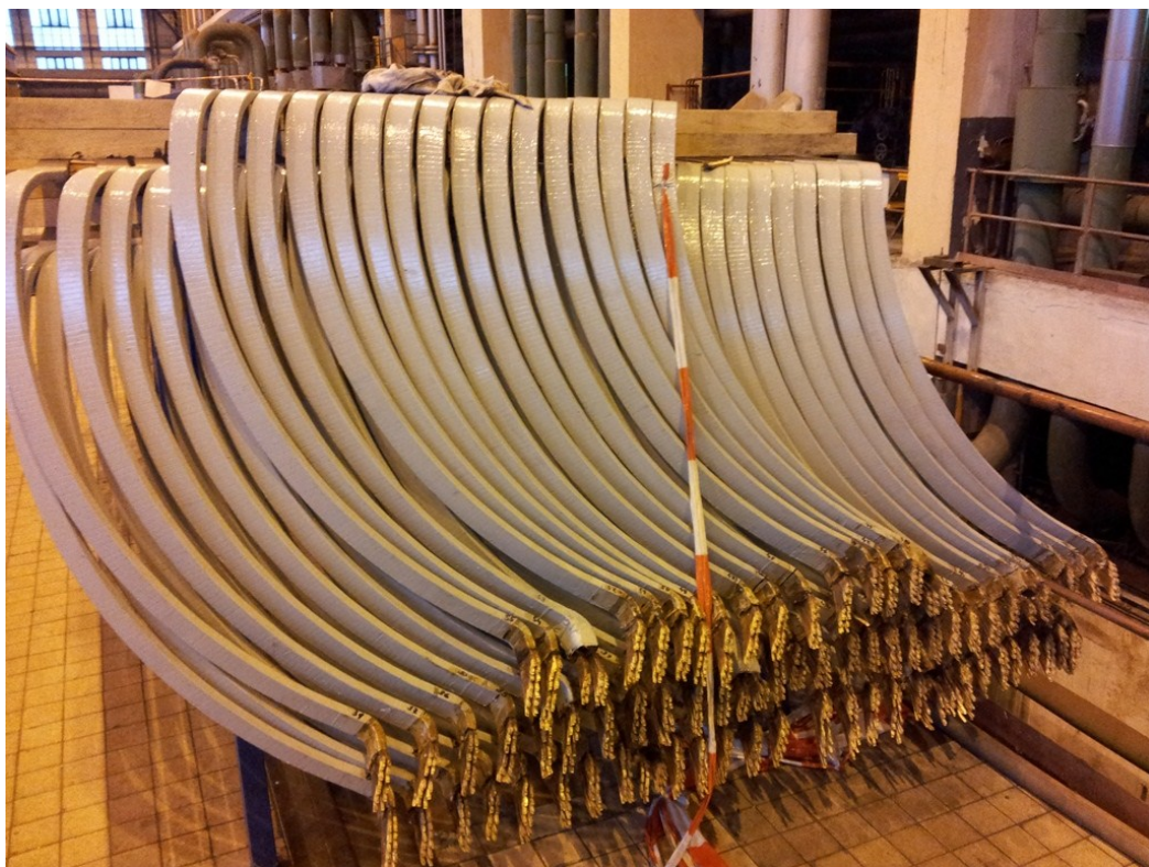
Obr. 1.30 Demontované a označené statorové tyče TG3 připravené ke zkoušení
