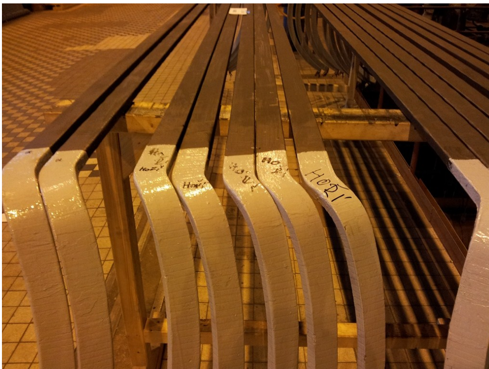
Obr. 1.31 Demontované a označené statorové tyče TG3 připravené ke zkoušení
