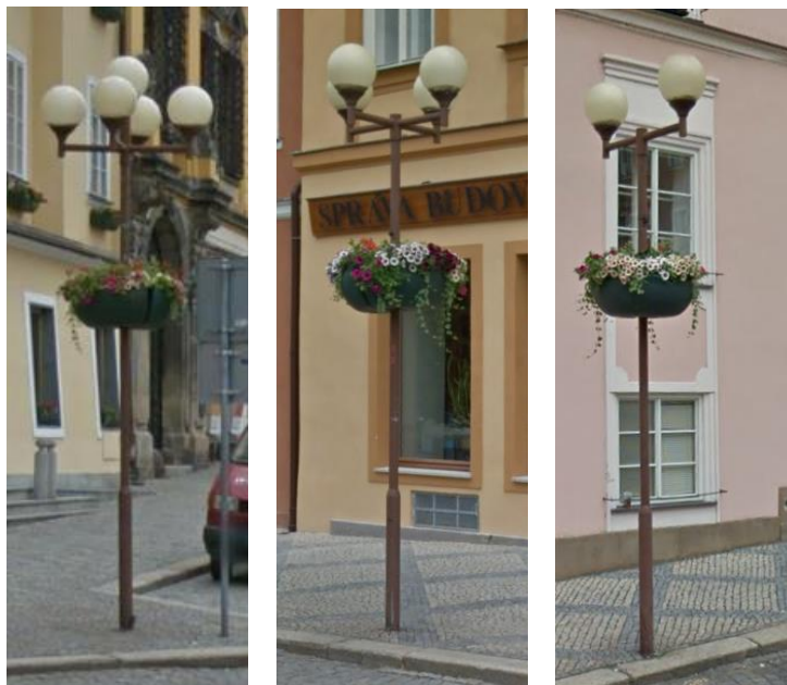
Obr. 3.1.2 a) světelné místo s pěti svítidly b) místo se čtyřmi svítidly c) místo se dvěma svítidly
