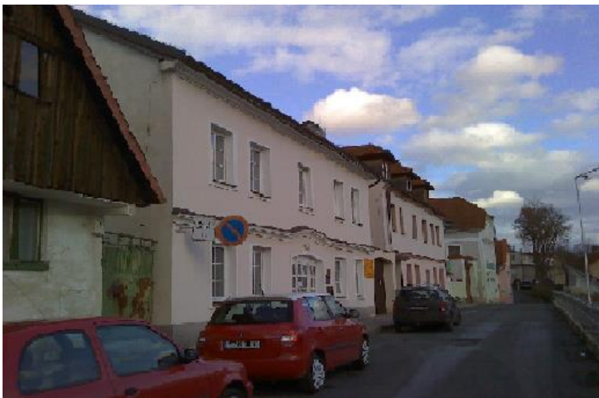
Obr. 4.1 Pohled na budovu – jižní strana
