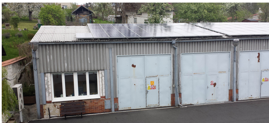
Obr. 1.6 Pohled na objekt skladové haly
