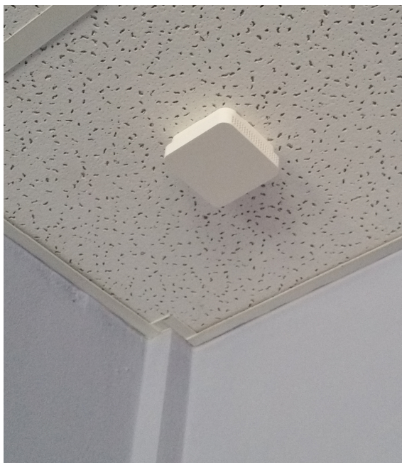
Obr. 2.5 Prostorové teplotní čidlo PT 1000
