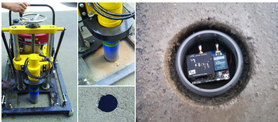
Obr. 2.2: Instalace a výsledné provedení podpovrchového detektoru |Převzato z [13],[14]|
