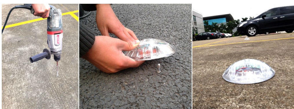
Obr. 2.3: Instalace a výsledné provedení povrchového detektoru |Převzato z [15]|
