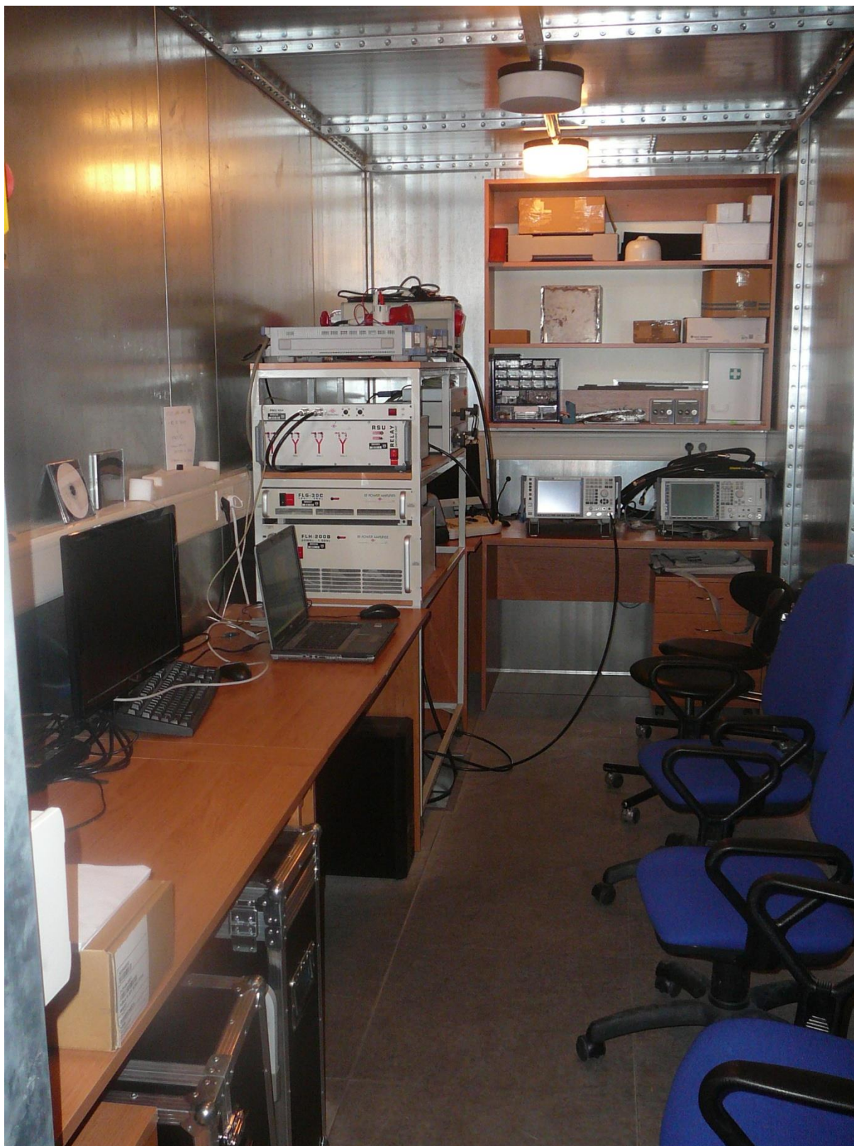
Obr. G4 Vedlejší vyhodnocovací komora na ZČU v Plzni.
