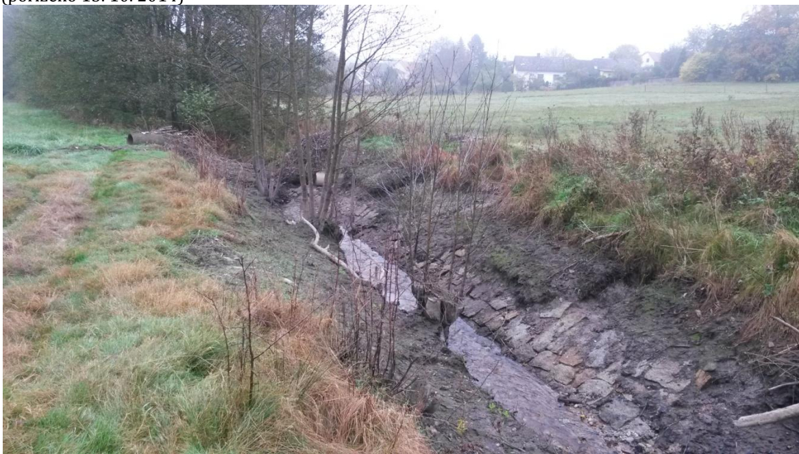
Obrázek 19: Příklad napřímeného koryta Černého potoka zpevněného kamennými dlaždicemi (pořízeno 13. 10. 2014)
