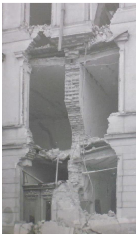
Příloha č. 17: Zřícení východního křídla staré školní budovy 245
