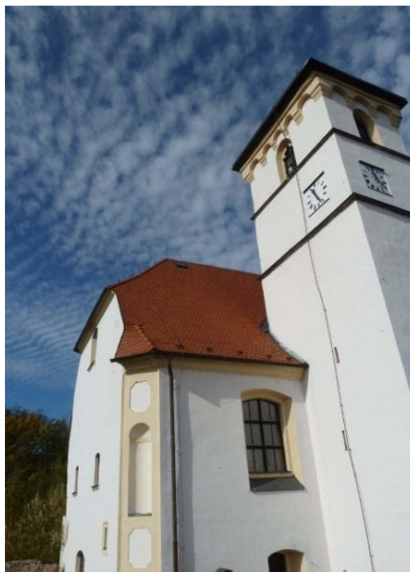
Příloha 9: Kostel Povýšení sv. Kříže 124
