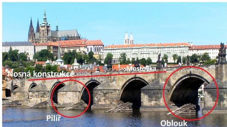
Obrázek 1 – Popis konstrukce mostu
