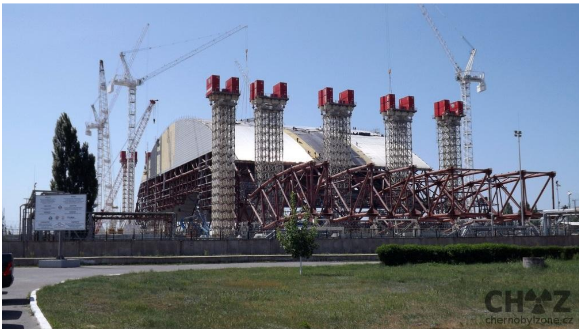
Příloha 9- Stavba nového sarkofágu (dostupné z: http://chernobylzone.cz/foto-chernobylska-exkurze-2013/nggallery/page/7 )
