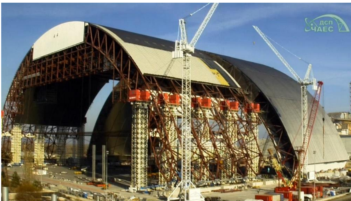
Obrázek 2- Stavba nového sarkofágu ke dni 30. 10. 2014
