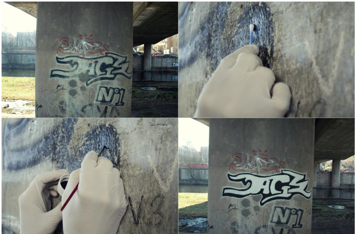
Obrázek č. 8 - Restaurování graffiti
