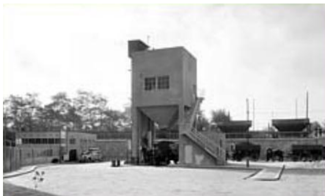
Obrázek 4: Plnicí stanice stlačeného svítiplynu v areálu Pražské obecní plynárny v Michli [10]
