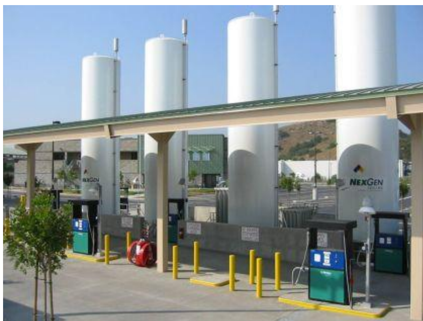
Obrázek 8: Plnicí stanice se šesti stojany LNG a třemi stojany LCNG pro městské služby v Los Angeles [17]
