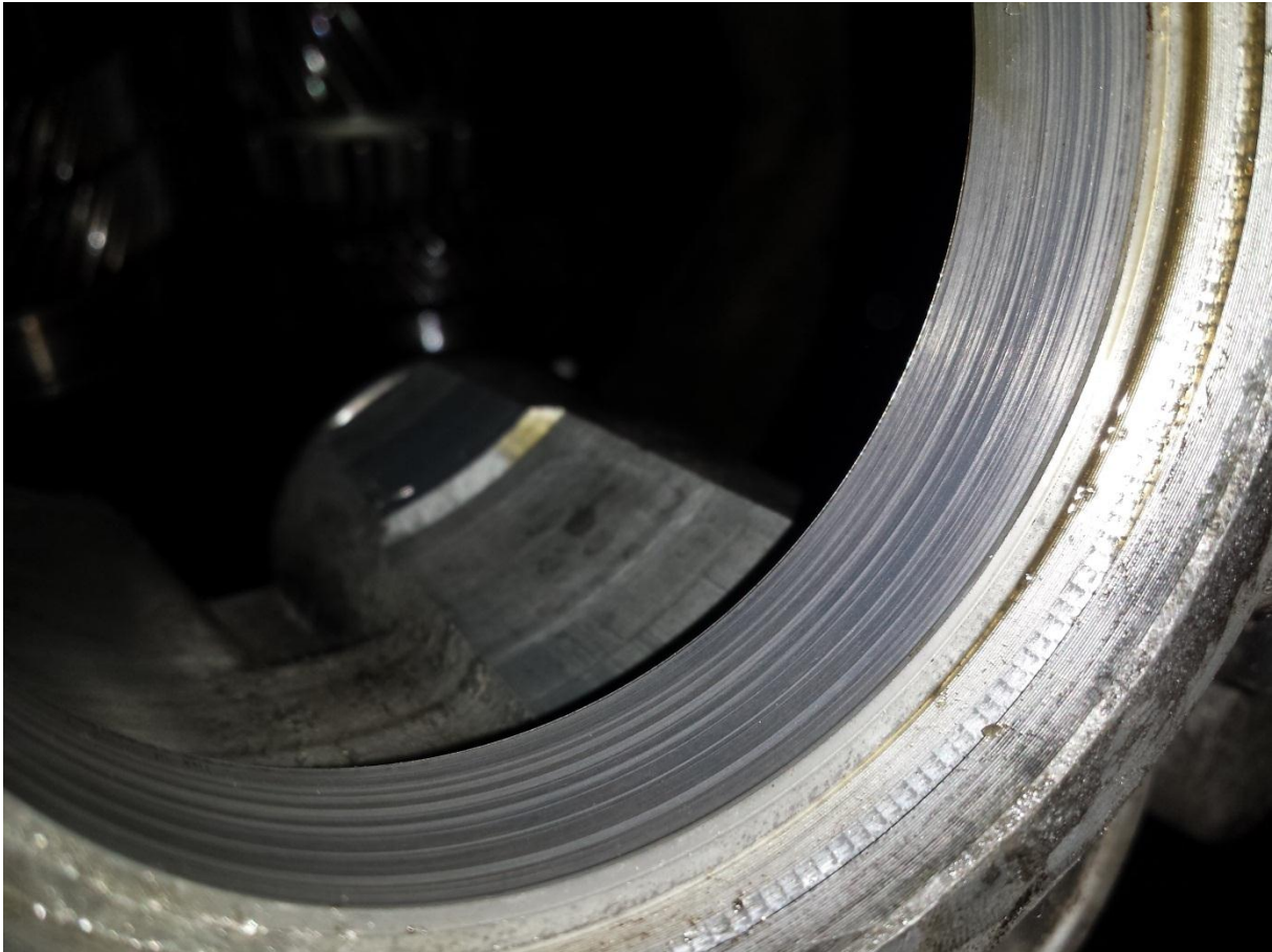
Obr. 4.6: Detail poškození uložení valivého ložiska v převodové skříní
