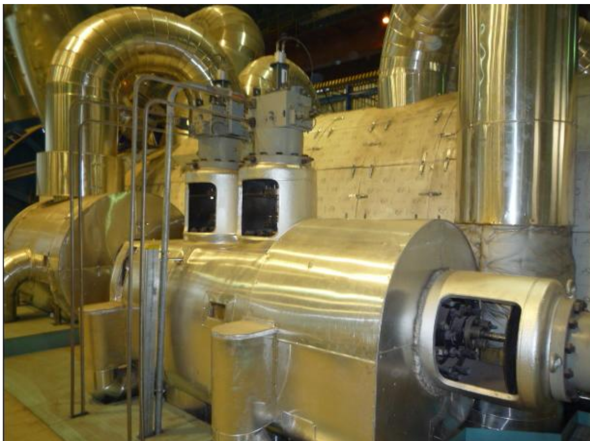
Obrázek 10 – VT RZ ventil po ukončení montáže a zaizolování [10]
