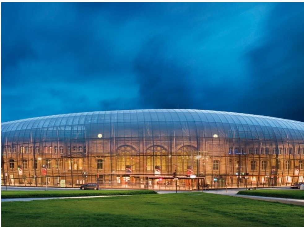
Obrázek 2 Nádraží ve Štrasburku ve Francii Dostupné na: http://seele.com/structure-en/railway-station-strasbourg.html
