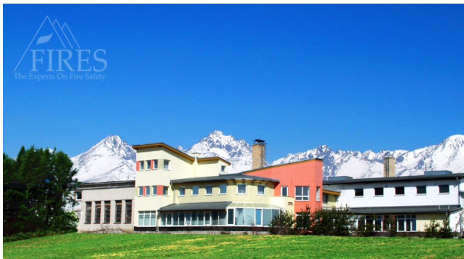
Obr. A-1: Budova sídla a zkušebny společnosti Fires, s.r.o.
