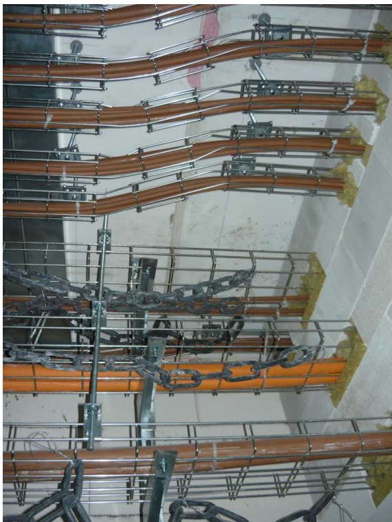
Obr. A-5: Pohled na vzorky ve zkušební komoře před zkouškou; v horní části fotografie je vidět změna směrového vedení trasy ve tvaru „S“ kabelů s hnědým pláštěm, jedná se o trasy G2 až G6; trasy ve spodní části fotografie jsou trasy M7 až M9
