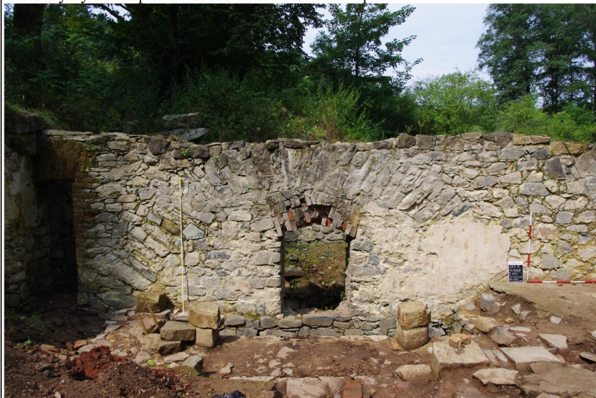
Obr. 52. Návodní zeď vodního mlýna K20. Nad otvorem pro hřídel je patrný mohutný vynášecí pas. Sezóna 2014. Pohled od západu.
