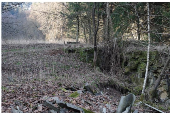
Pohled na Zourovský mlýn a hráz od severozápadu
