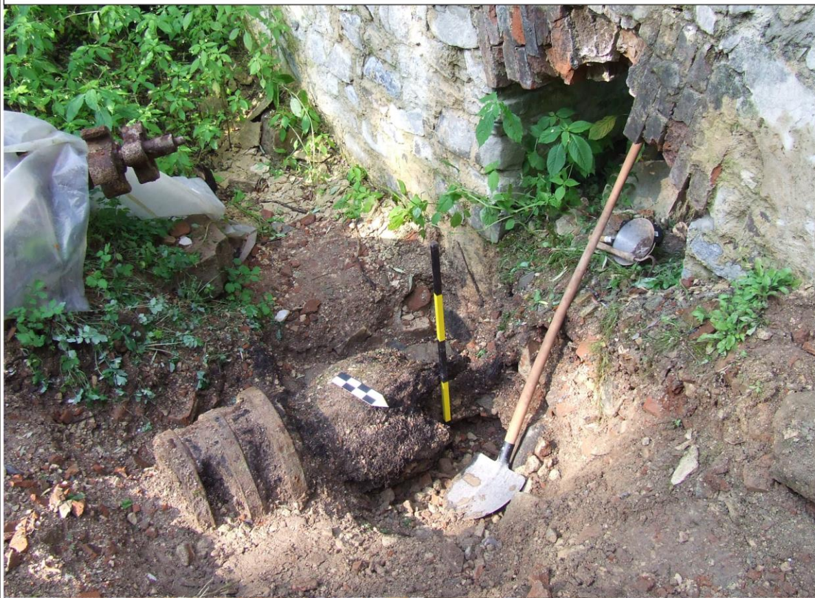
Obr. 57. Kapsa pro paleční kolo K503. Uvnitř konstrukce byly zjištěny pozůstatky technologie (fragменты palečního kola a transmise s dřevěnou řemenicí).
