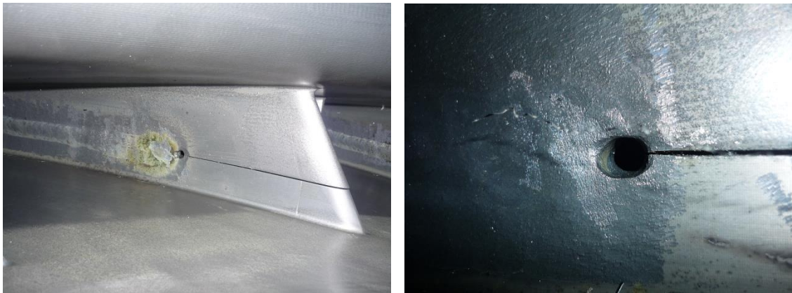
Obr. 3: Ukázka technologického otvoru
