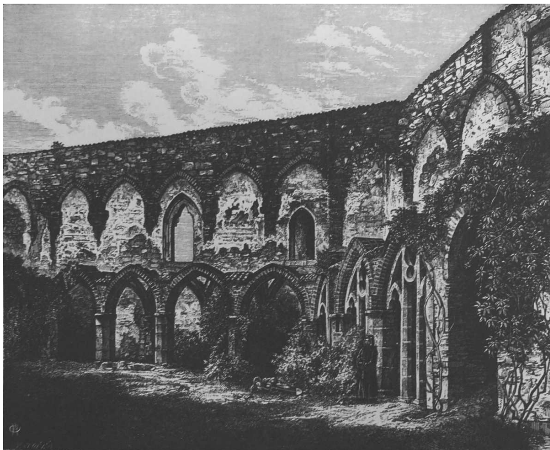
Obrázek č. 64: Zvíkov. Stav arkád před započítím oprav. Zdroj: Sedláček 1997b: 9
