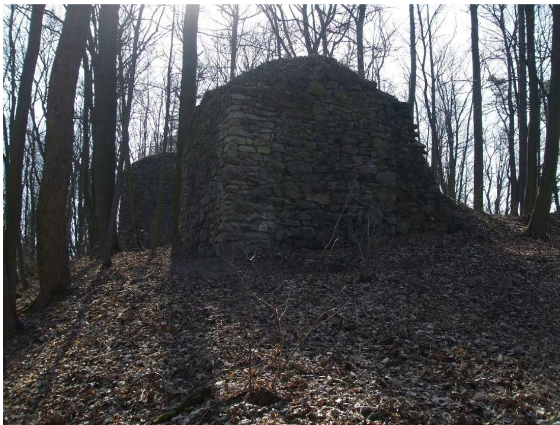
Obrázek č. 49: Prácheň. Pohled na čtvrtou a v pozadí třetí flankovací věž směrem od velké věže (rok 2015). Foto autor
