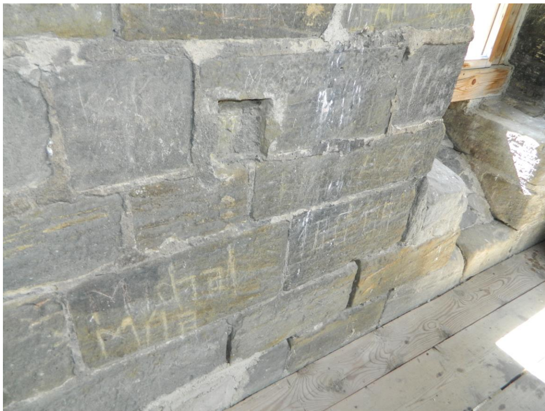
Obr 14: Jedna z kapes v interiéru Bílé věže na Házmburku – foto autor
