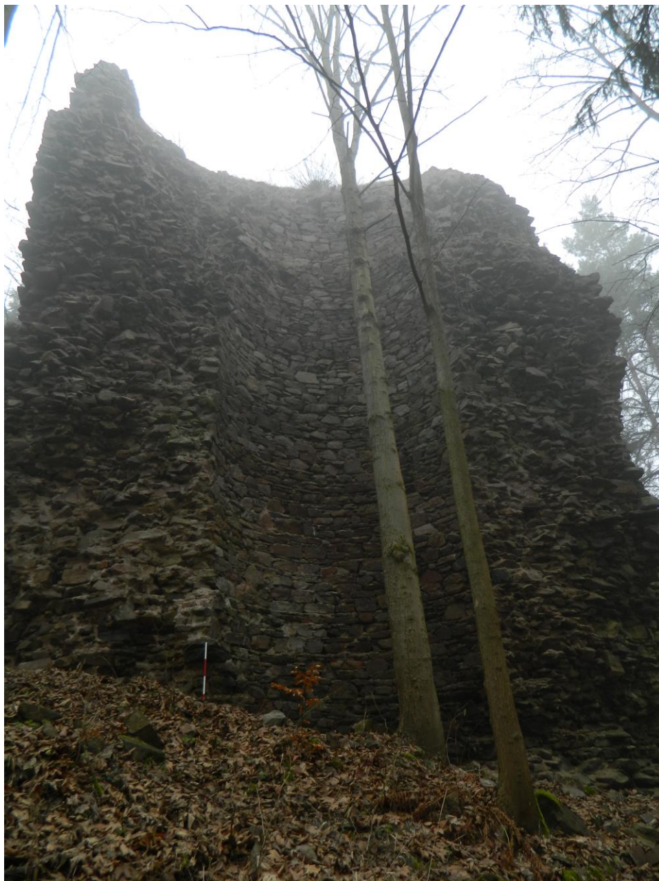
Obr 10: Interiér perštejnského bergfritu – foto autor
