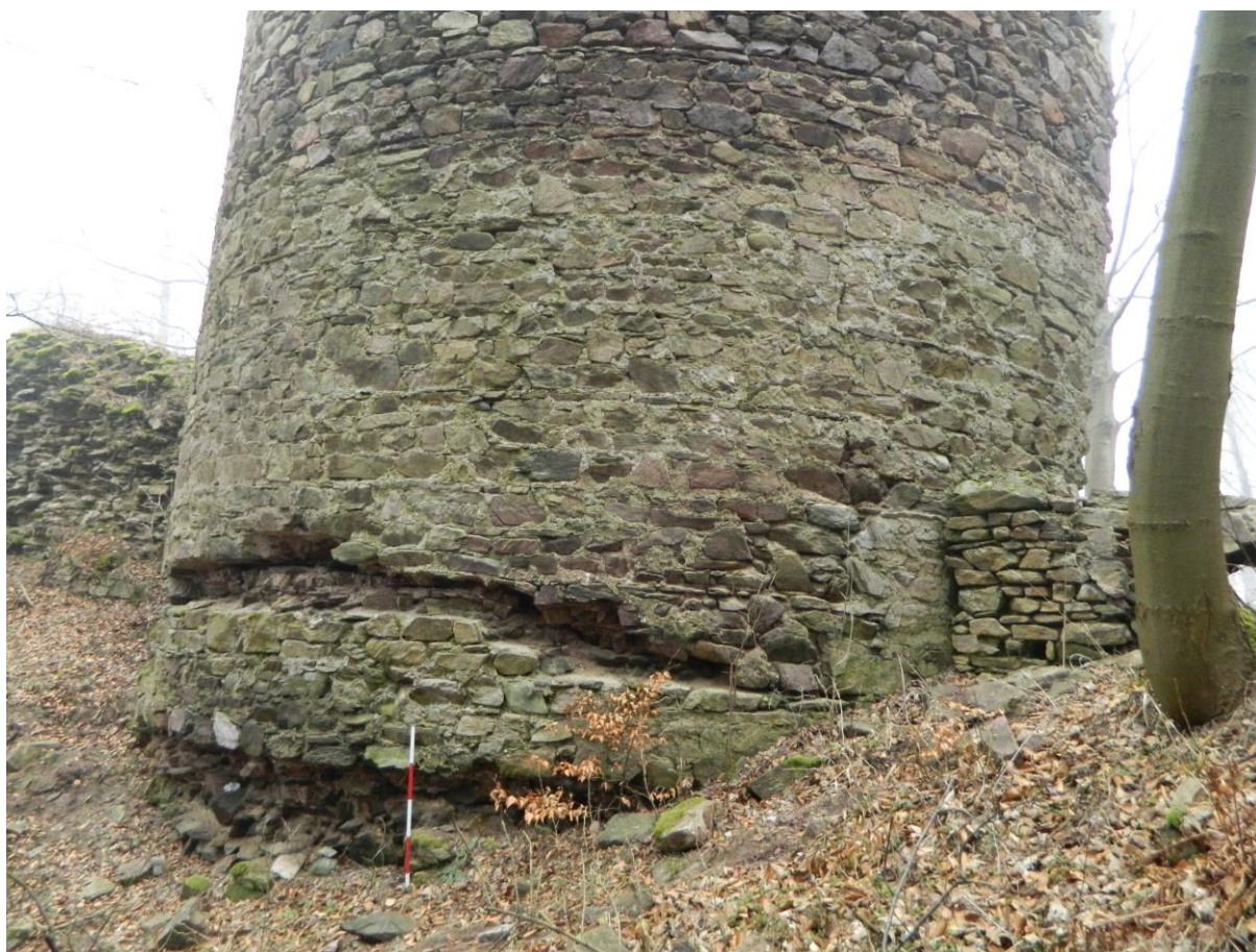
Obr 8: Bergfrit hradu Perštejna, na snímku zachyceny kaverny ve vnějším líci – Foto autor
