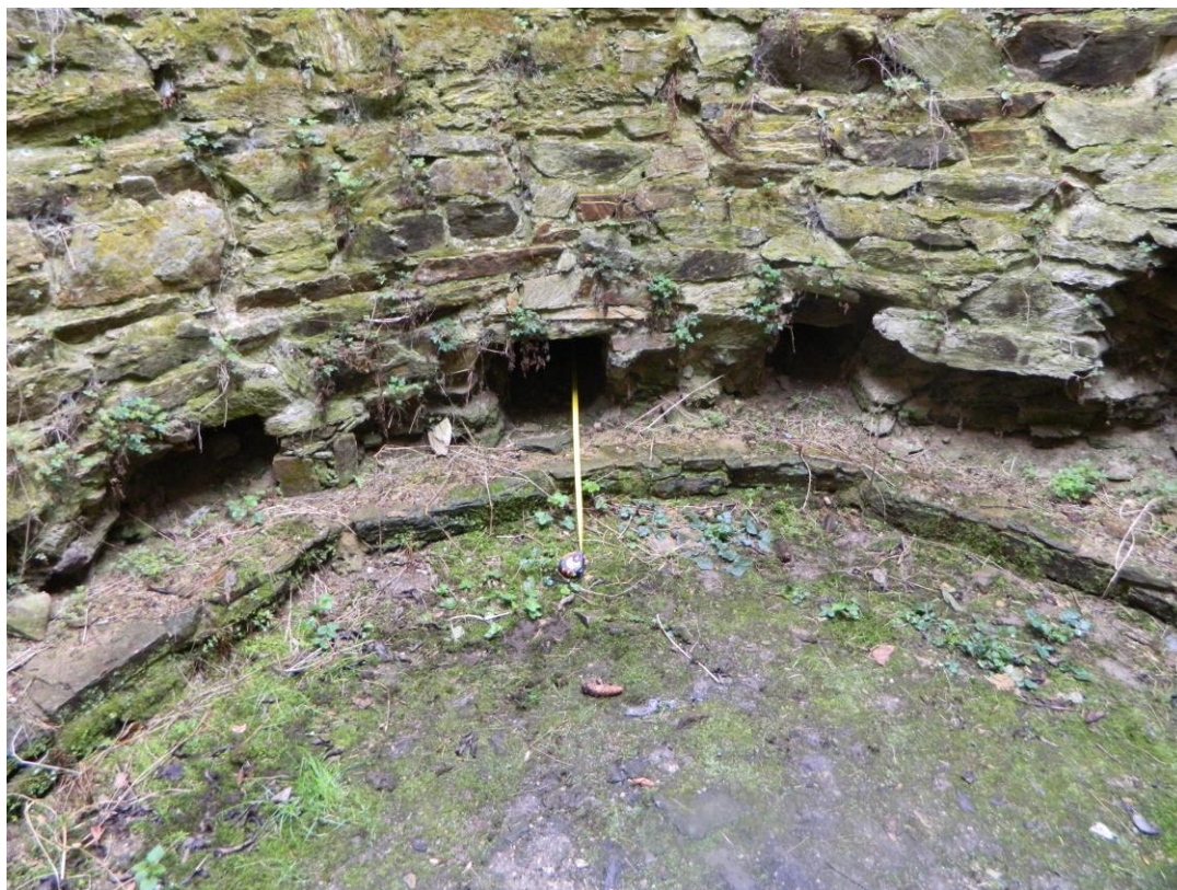
Obr 7: Ústupek zdiva a kapsy po trámech podlahy přízemí, bergfrit Talmberka – Foto autor
