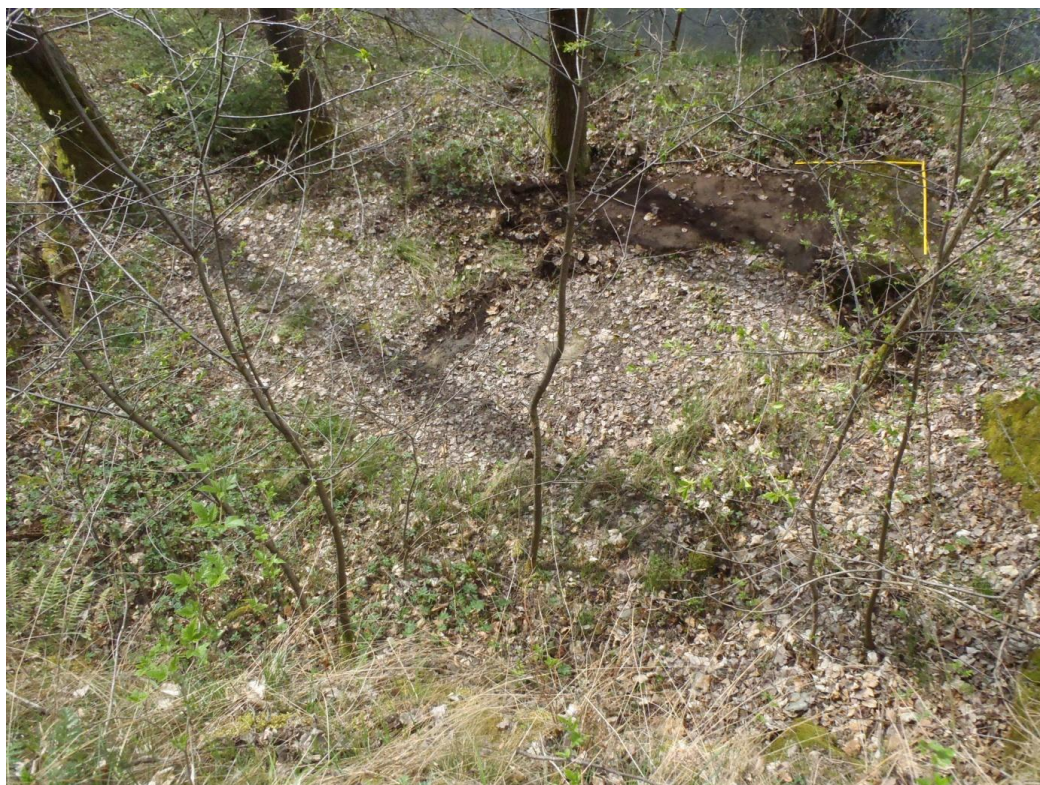
Obr. 13: Obj. č. 27 Základová deska pro LO vz. 37 (údolí Úterského potoka) - jaro 2014
