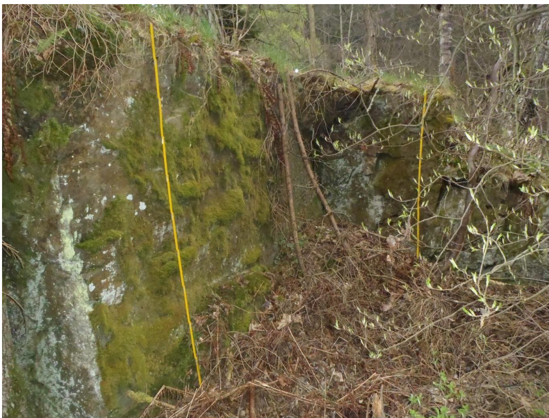
Obr. 5: Obj č. 1 Úkryt vylámaný do skály (údolí Úterského potoka) - jaro 2014
