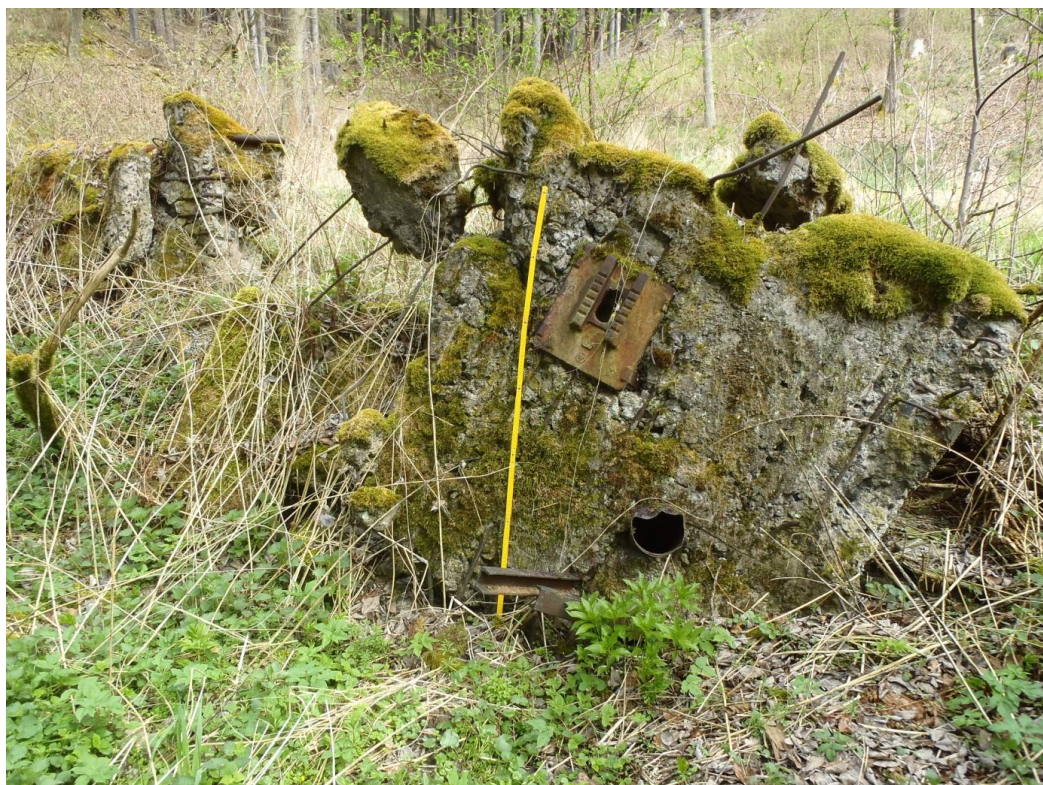
Obr. 11: Obj. č. 14 Detail vstupní střílny (údolí Úterského potoka) - jaro 2014
