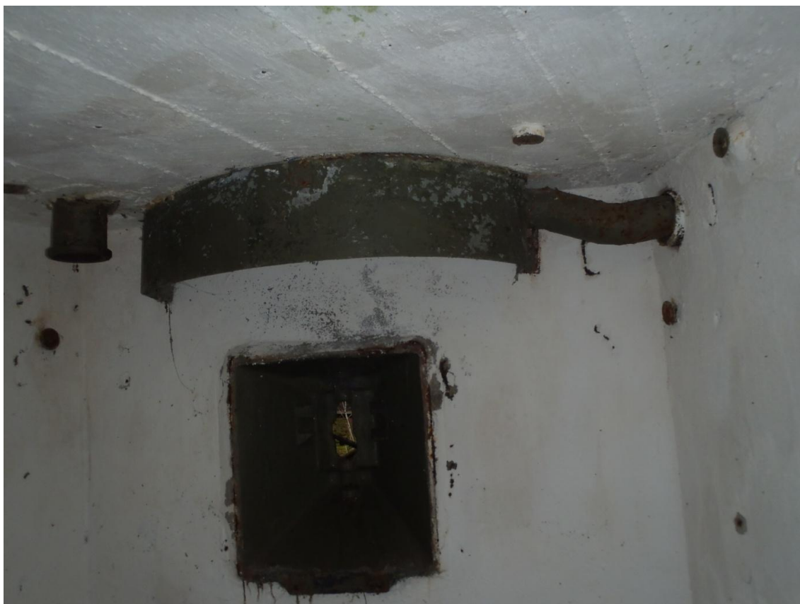
Obr. 36: Obj. č. 74 Pláň (okr. Plzeň - sever) interiér LO vz. 37 - detail lapače zplodin a uchycení periskopu - podzim 2014
