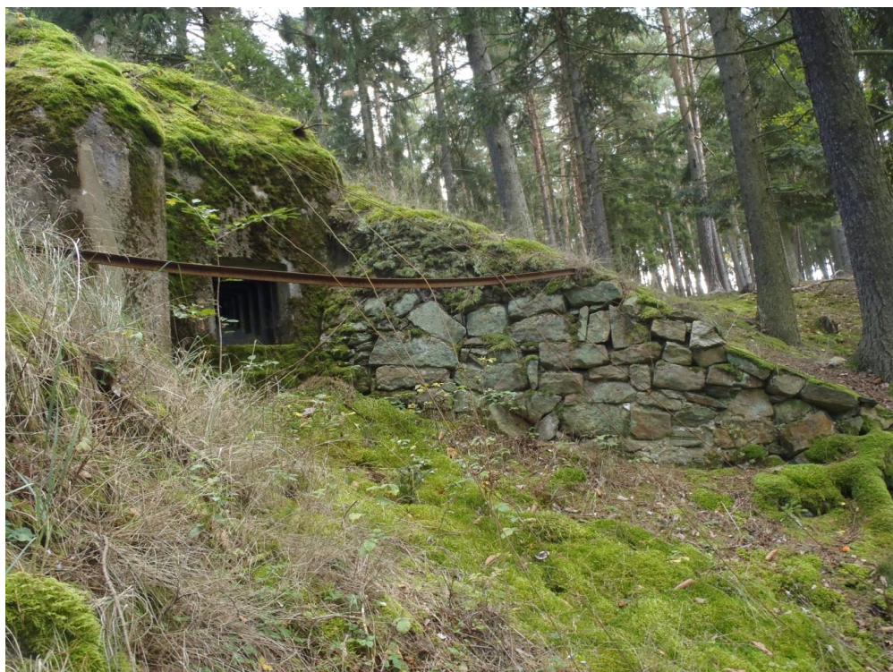
Obr. 21: Obj. č. 43 Pakoslav (okr. Plzeň - sever) kamenná zídka kryjící střílnu - podzim 2014
