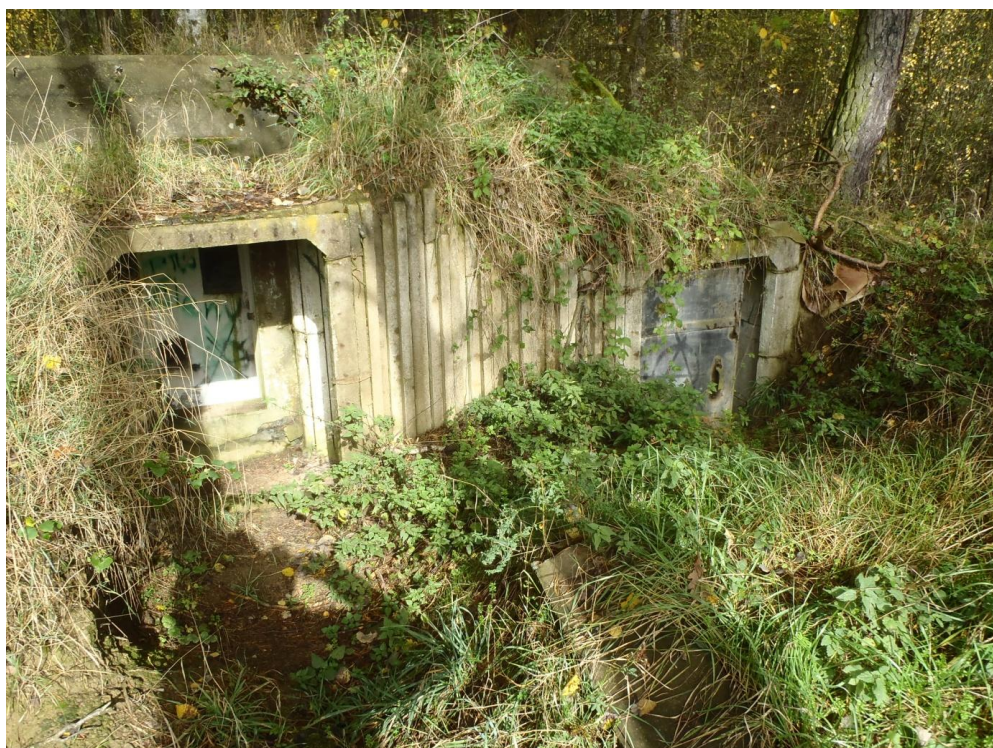
Obr. 35: Obj. č. 73 Pláň (okr. Plzeň - sever) LO vz. 37 se vstupní chodbičkou z prefabrikovaných dílů podzim 2014
