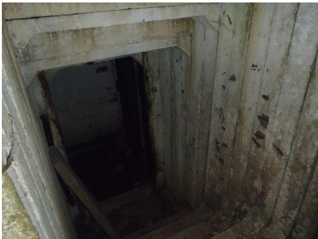
Obr. 9: Obj. č. 12 a 13 Detail vstupní chodbičky z prefabrikovaných dílů (údolí Úterského potoka) - jaro 2014
