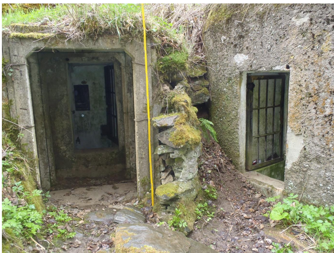
Obr. 8: Obj. č. 12 a 13 Detail vchodů LO vz. 37 (údolí Úterského potoka) - jaro 2014
