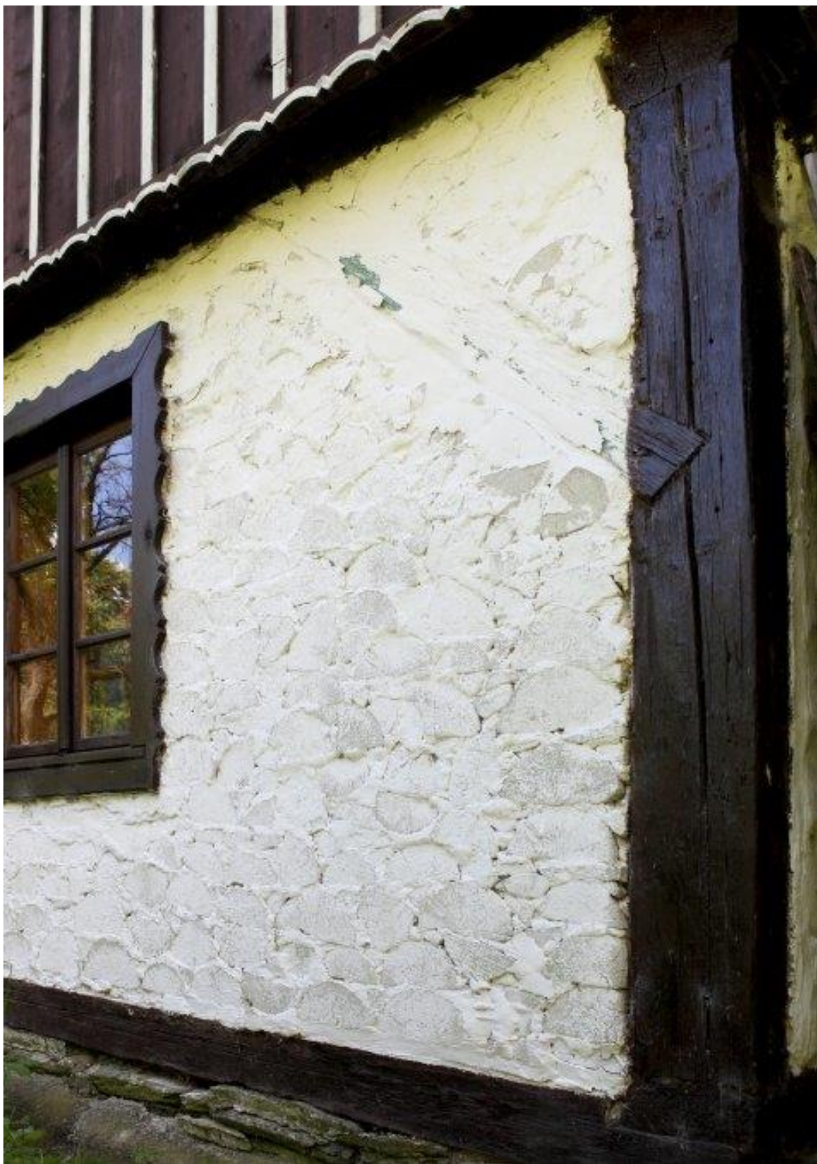
Obr. 40. Horní Štěpánice čp. 3 – detail krčkového zdiva (19. století)
