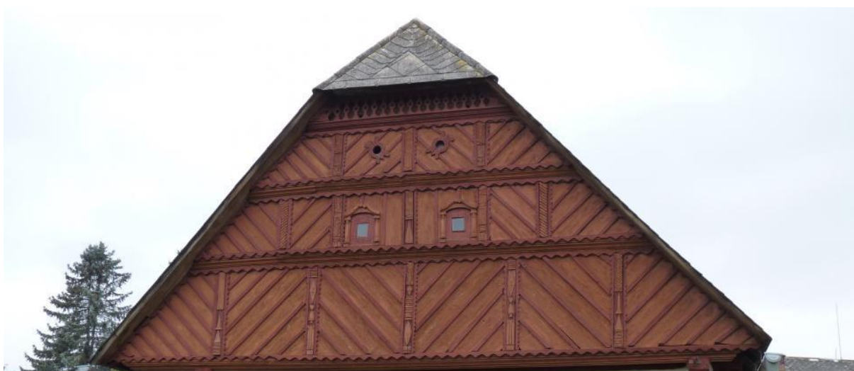
Obr. 38. Lomenice tzv. Novoveského typu (Nová ves nad Popelkou čp. 30)
