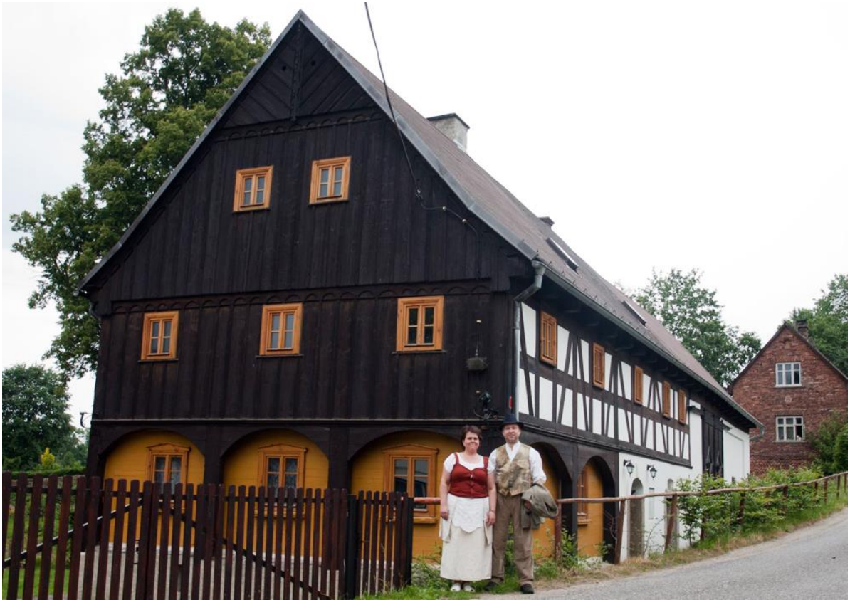
Obr. 46. Šetrně zrekonstruovaný podstávkový dům čp. 25 v Raspenavě (polovina 18 století; před domem stojí majitelé objektu)
