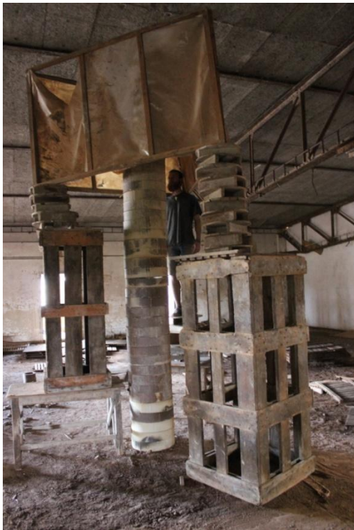
Hala II. – vztyčování věže 15
