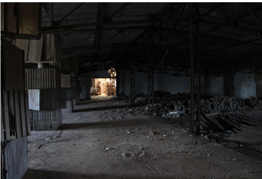
Hala II. – po instalaci věží 13
