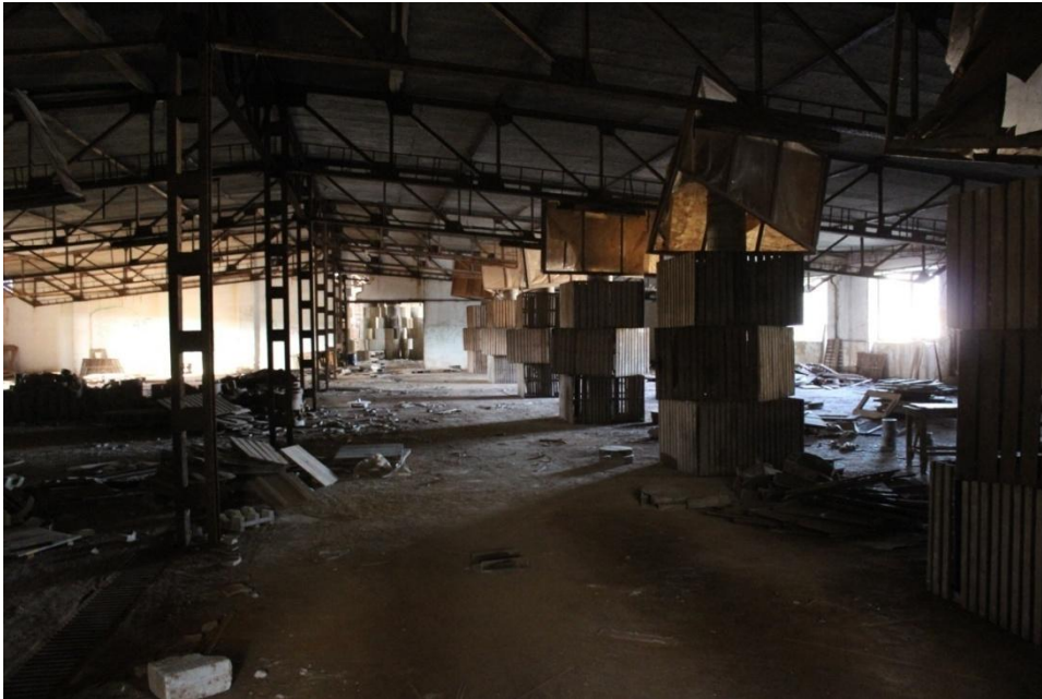
Hala II. – po instalaci věží 14
