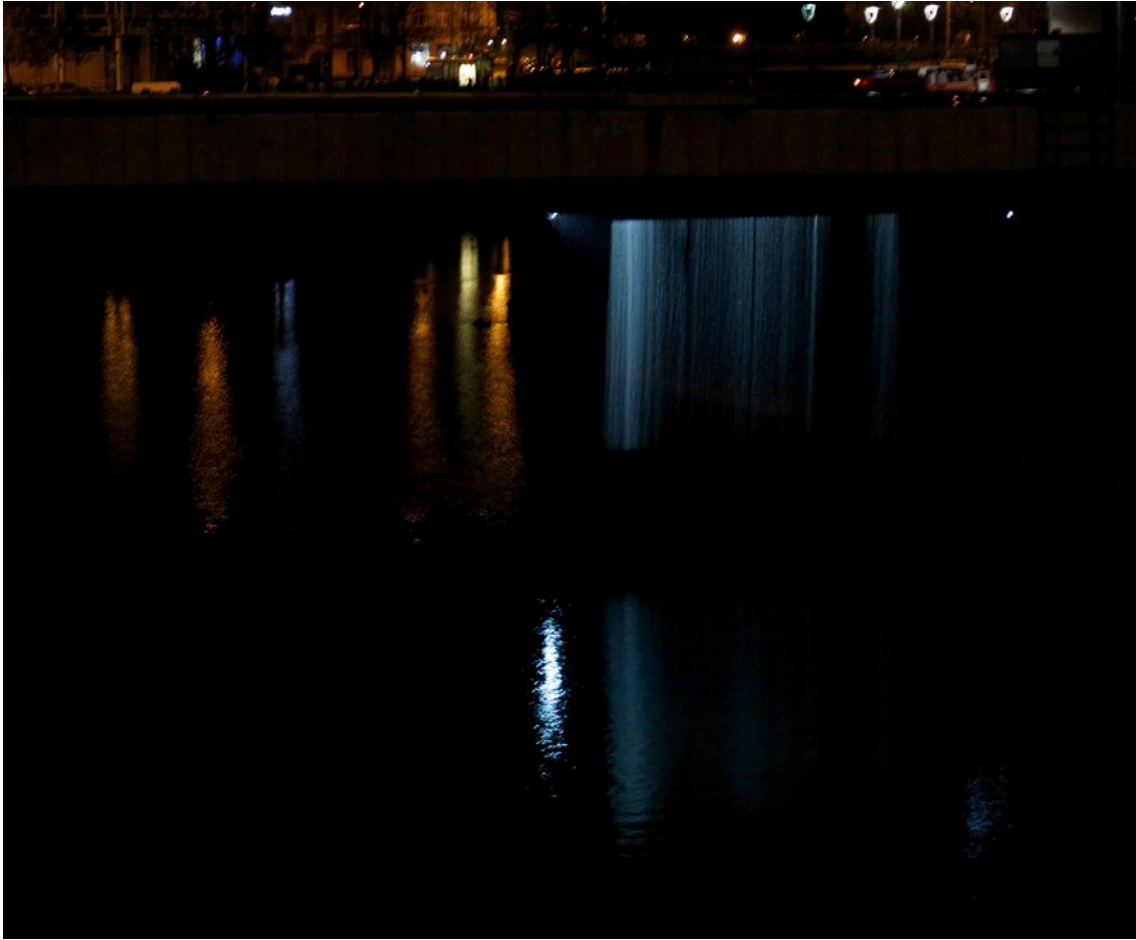
Příloha 12: Vodní stěna – osvětlená padající voda
