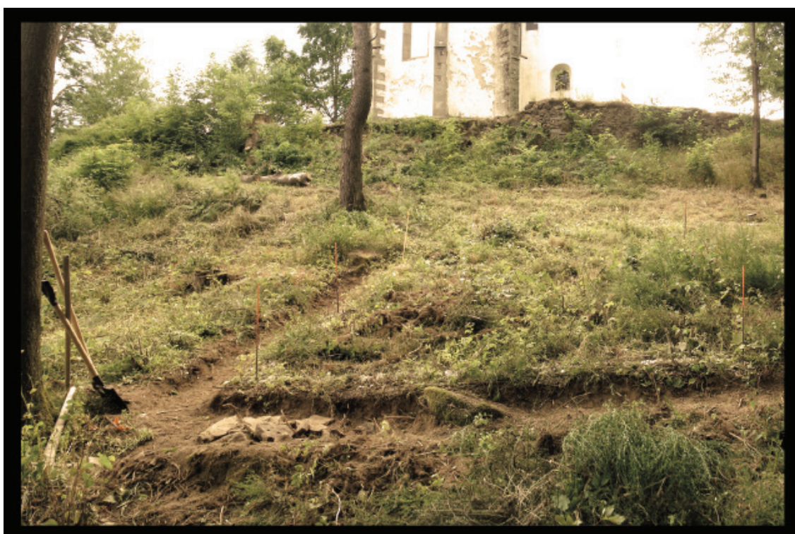
Příloha č. 16: Příprava základů
