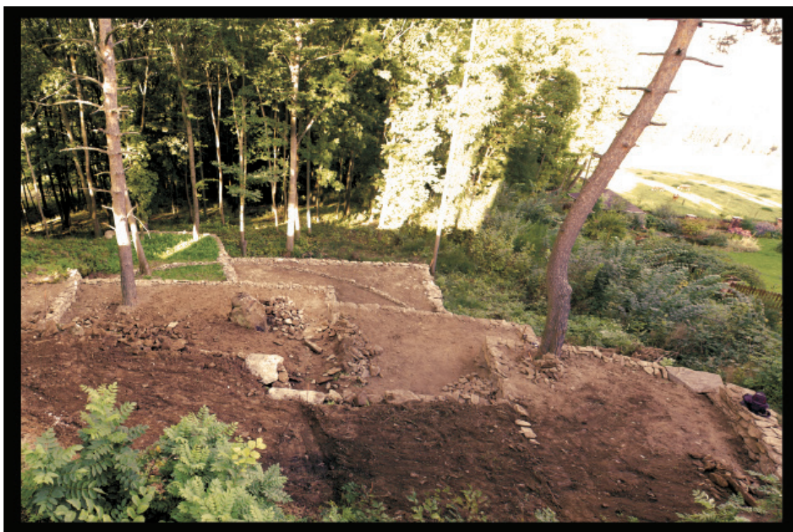
Příloha č. 19: Dokončovací práce
