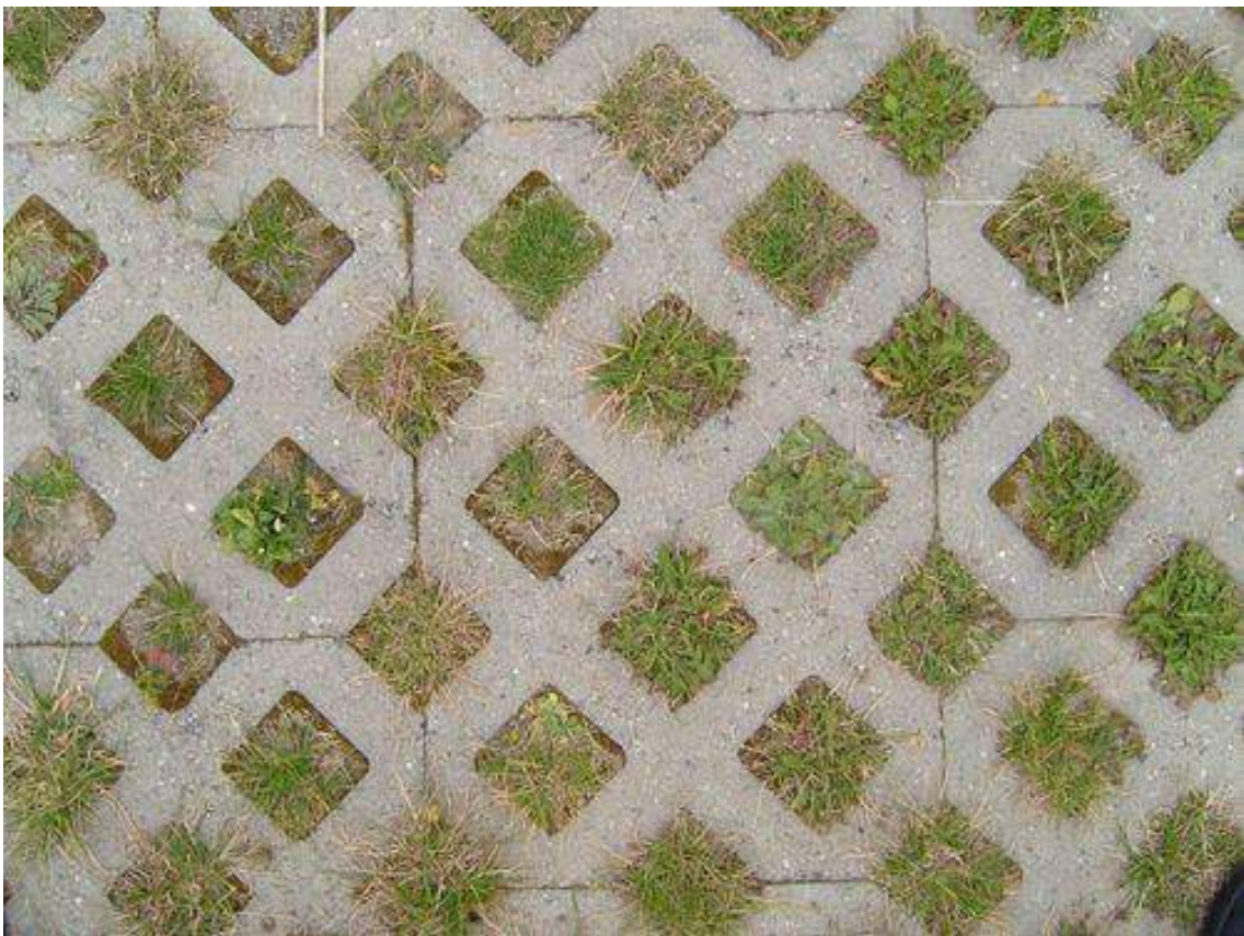
11.2. 2. Zatravnovací dlažba
