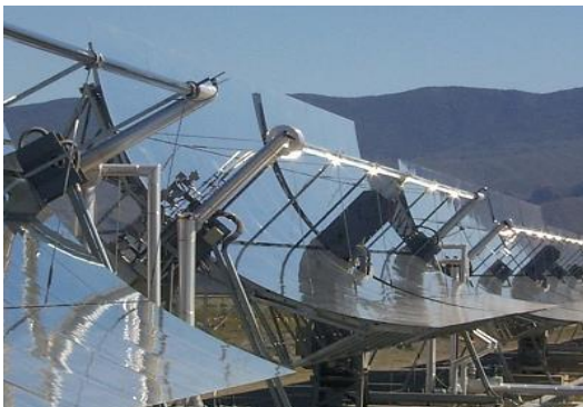
Obrázok. 1 Lineárne parabolické zrkadlá
