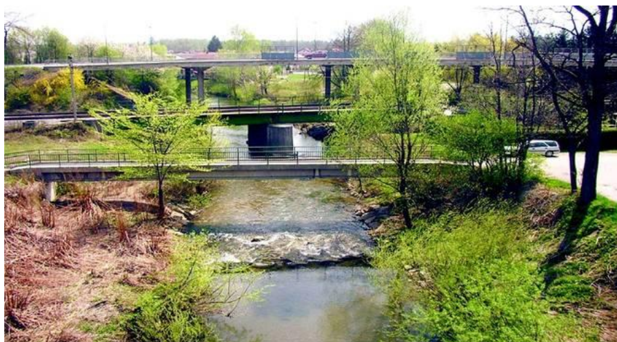
Slika 38 : Pogled na Mali graben pri Dolgem mostu z viadukta avtoceste ( http://www.delo.si/novice/slovenija/potek-poplave-in-predlog-protipoplavne-zascite.html )
