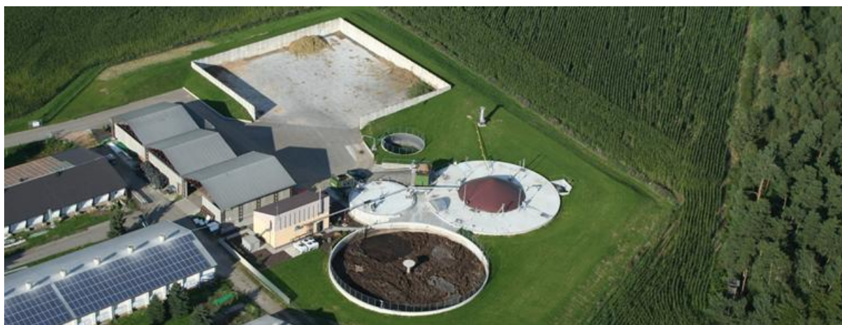
Obr.: 2 Bioplynová stanice Vejprnice [c]
