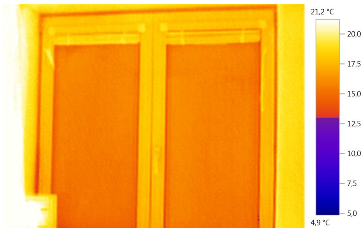
Obr. 12 – Okna zatepleného bytu. Nejnižší teplota skla 16°C. Okna nezatepleného bytu. Pohled z bytu
