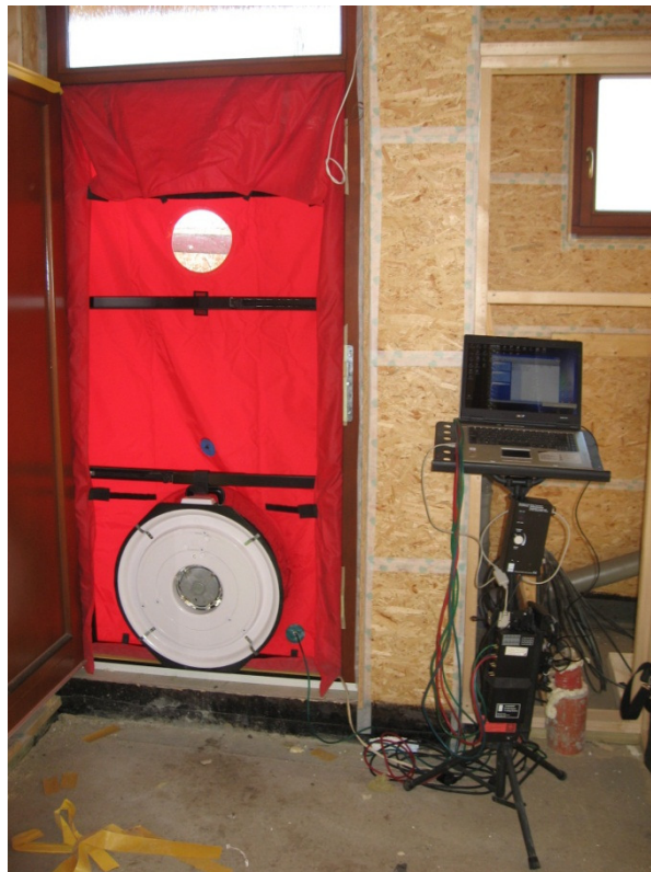
Obr. 11 Provedení Blower Door testu ve fázi rozestavěnosti [28]
