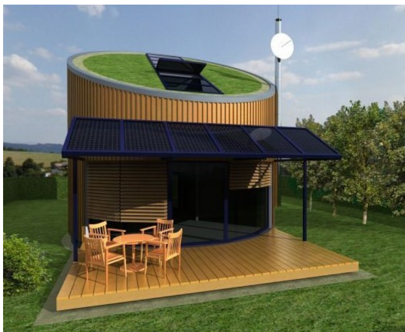
Obr. 3 Malý objem je kompenzován válcovitým tvarem stavby, název stavby: Nízkoenergetický dům Rondo, autor projektu: Ing. arch. Josef Smola, [7]
