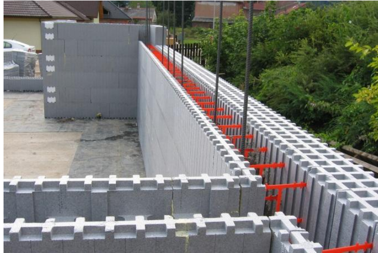
Obr. Systém ztraceného bednění (převzato z:[20])
