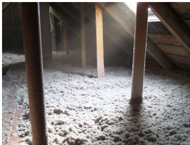
Obr.1.7.6.2-1 Foukaná celulózová tepelná izolace (převzato z:[24])
